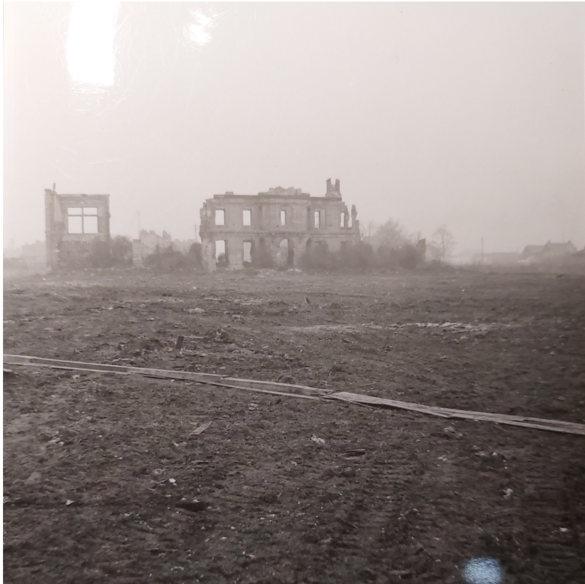
Figure 7: Le Château Mirabeau après la résorption du bidonville, février 1959, AN F1a5120
