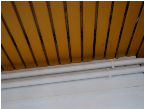
Figure 135 : Tuyaux visibles dans le couloir
