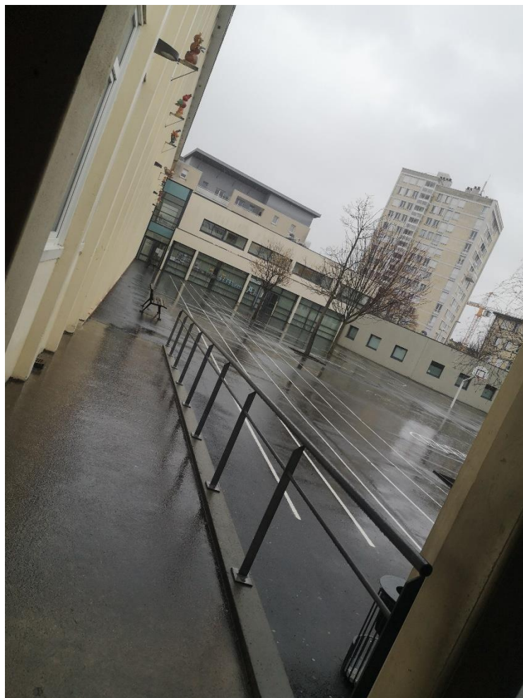
Figure 147 : Rampe d'accès à la cour - Ecole Reine Mathilde
