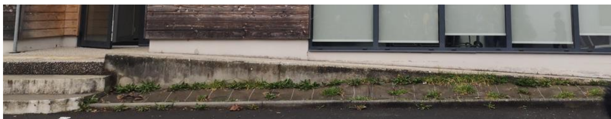
Figure 150 : Rampe d'accès pour le nouveau bâtiment Louvigny
