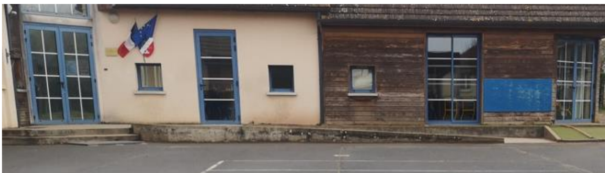
Figure 146 : Rampe d'accès devant entrée principale Hérouvillette
