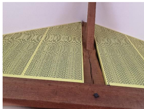
Figure 78 : Poutres salle orchestre Hérouvillette
