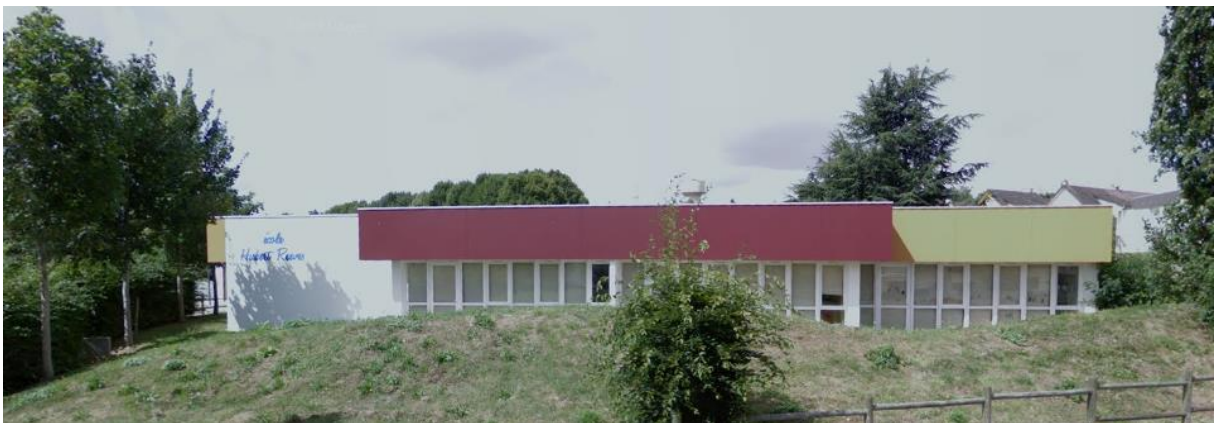
Figure 42 : Bâtiment extérieur école Louvigny 2008 (Google Map)
