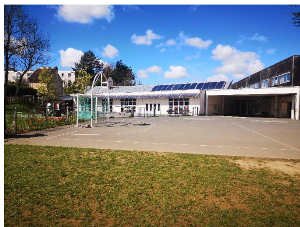
Figure 39 : Panneaux solaires sur le toit de la Haie Vigné
