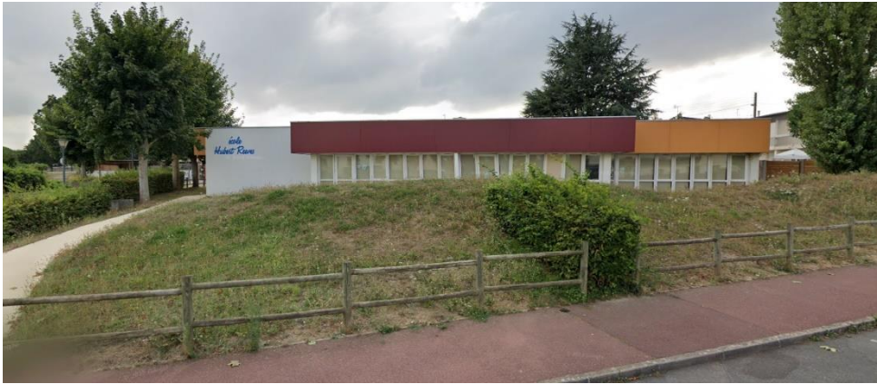
Figure 41 : Bâtiment extérieur école Louvigny
