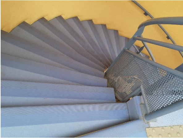
Figure 72 : Escalier qui mène à la salle en haut
