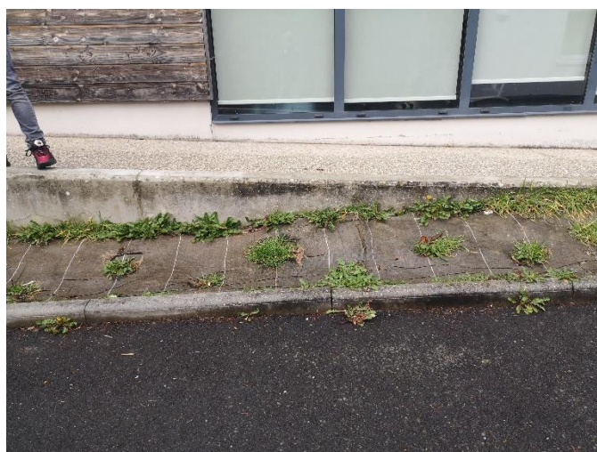
Figure 216 : Rampes pour fauteuil roulant que les enfants utilisent comme terrain de billes (Louvigny)
