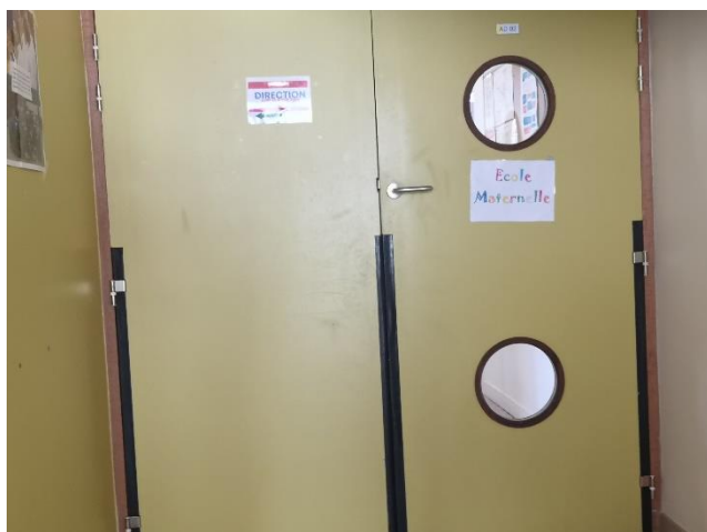
Figure 110 : Porte qui relie le hall et l'espace maternel (gars)
