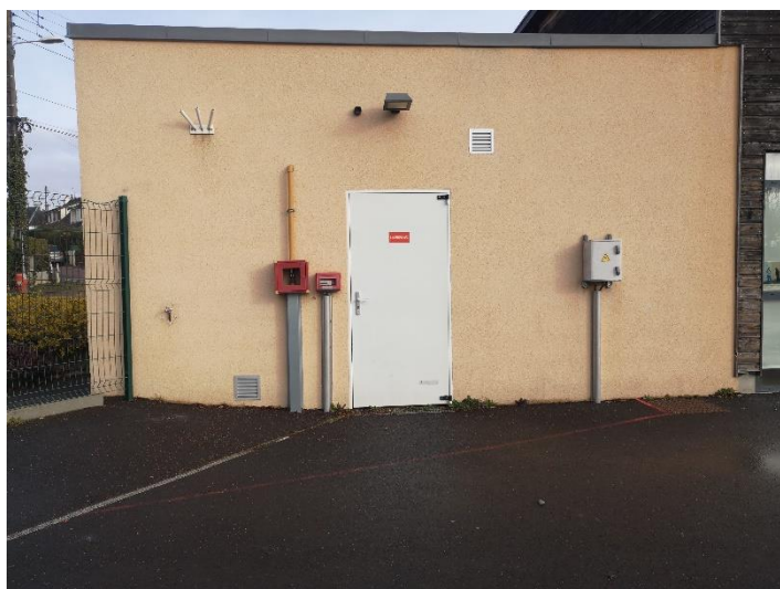
Figure 134 : Local électrique et chaufferie
