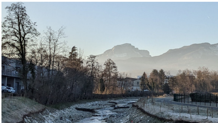
Figure 13 : l'Hyères après sa réhabilitation
