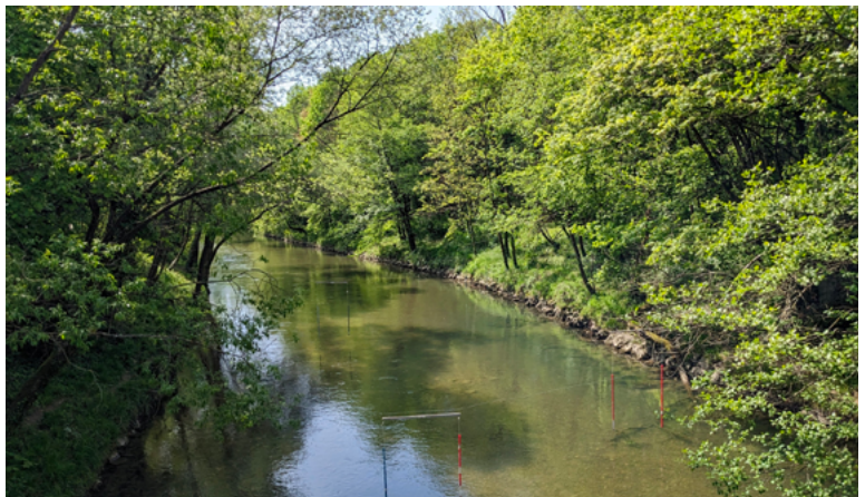
Figure 23 : La Leysse : La photo montre un état très artificialisé de la rivière, même dans ses sections les plus proches du lac, qui apparaissent plus naturelles. Le lit endigué est étroit et les berges sont abruptes.
