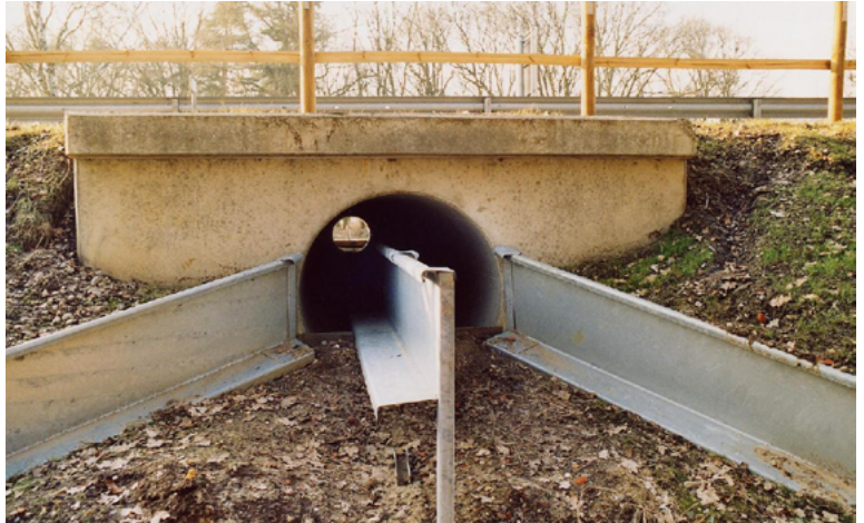
Figure 22 : exemple du "crapauduc" (passage souterrain pour faciliter la traversée de la route des amphibiens, mais également utilisé par d'autres espèces faunistiques)
