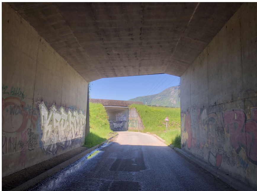
Tunnel des Taillats, 03/05/2023, photographie personnelle
