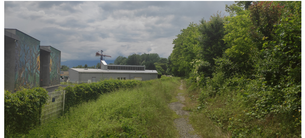
-Cheminement surelevé longeant la zone au nord ;mai 2023 ;réalisation: Petrel Lucas
