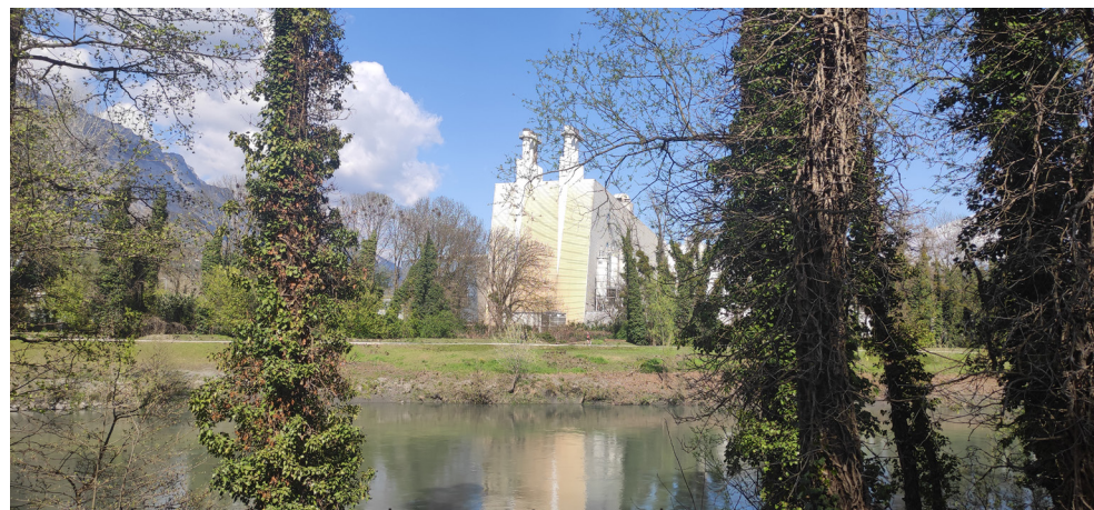
Vue sur l'incinérateur d'Athanor ; Gières ,avril 2023
