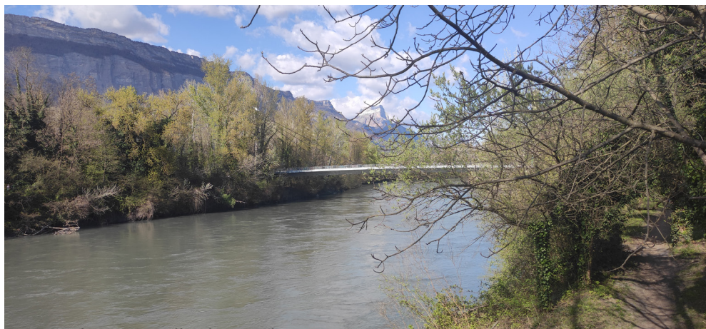
Vue sur la passerelle de Meylan ,Saint-Martin D'Hères,avril 2023
