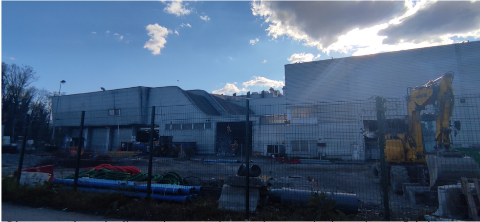
-Photographie de l'incinérateur depuis la rue de la tuilerie. Réalisation : Petrel Lucas; avril 2023.
