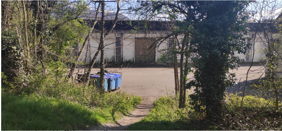
Accès entrepôt; Gières ,avril 2023
