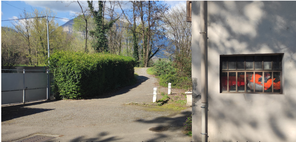
Entrée entre deux édifices peu visibles depuis l'extérieur de la digue, Saint-Martin d'Hères; avril 2023
