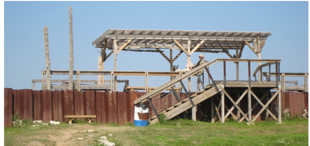
Figure 4 : la plateforme d'observation du Bayou Bienvenue
