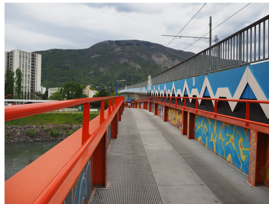
12 juin 2023, Passerelle des Taillées, photographie personnelle
