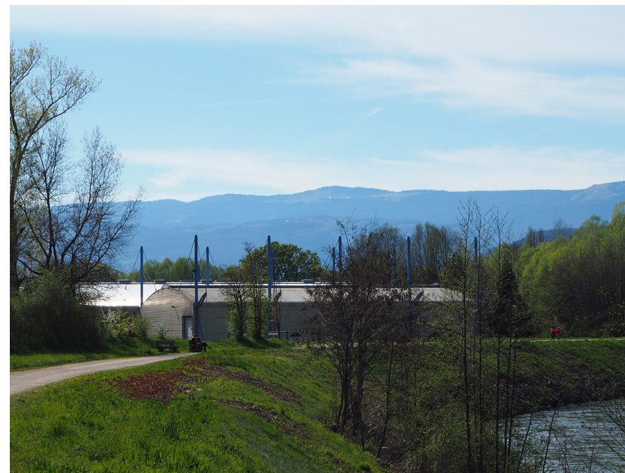
25 avril 2023, boucle des voûtes, photographie personnelle
