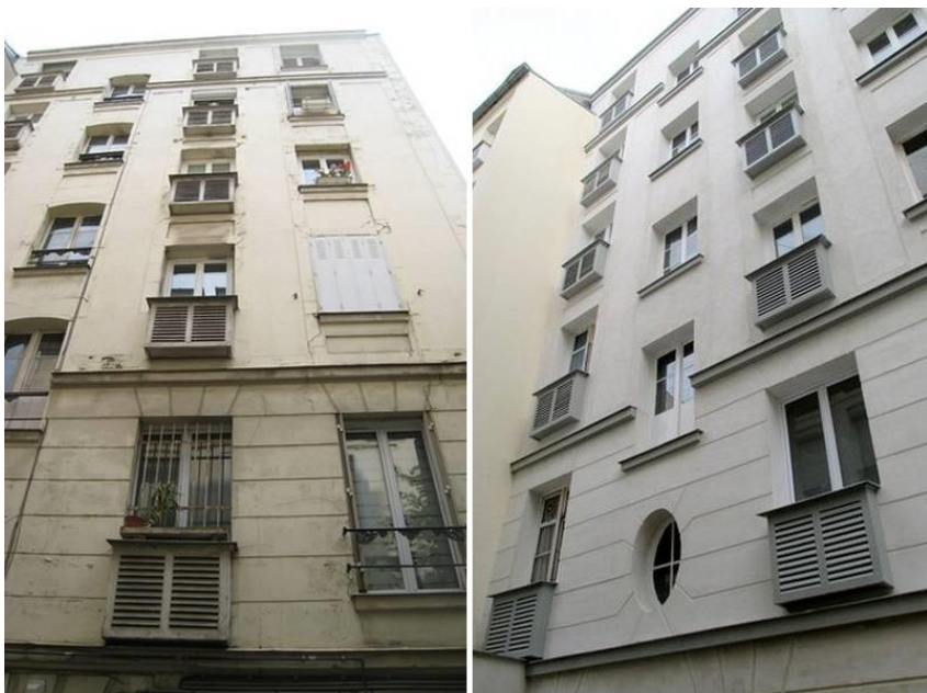
Photo 15 : Avant/Après Rénovation thermique d'un immeuble patrimonial rue de Couëdic à Paris - Source : north by northwest architectes
