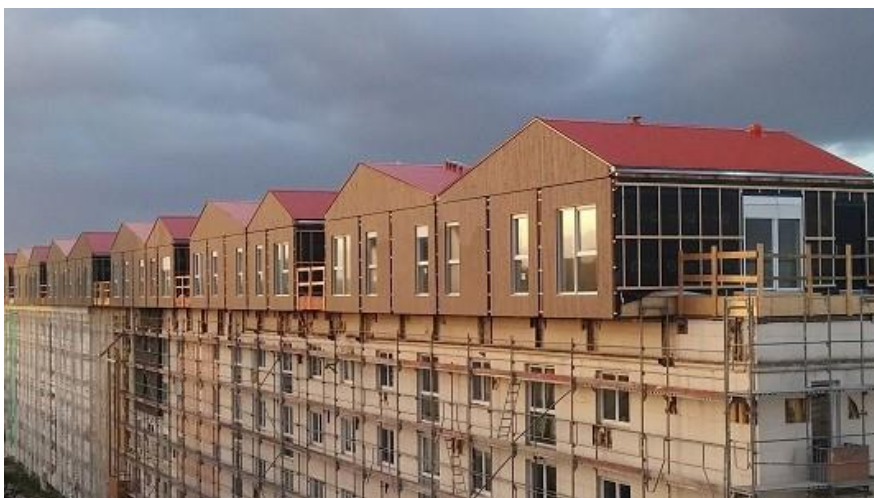
Photo 16 : Surélévation urbaine : Des maisons sur les toits des immeubles à Poissy - Source : news.cision.com
