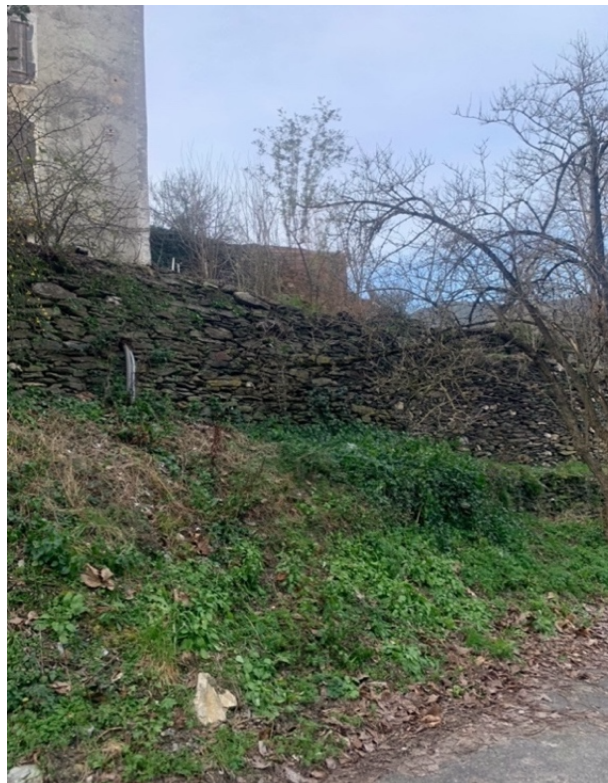
Figure 7 : Photographie d'un potentiel lieu de repos pour les phlébotomes avec présence de murs de pierre à Saint-André-De-valborgne (30). Source : photographie originale
