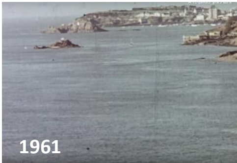
Figure 24 - Evolution du chantier de l'usine marémotrice de la Rance
