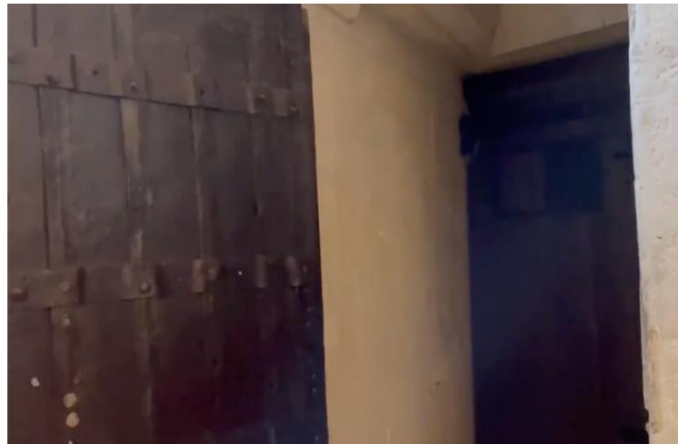
Figure 34 image du SAS du donjon de Vincennes ©CMN
