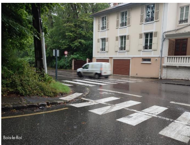
Photo 2 : Illustration d'une bande cyclable réalisée sur une voie piétonne
