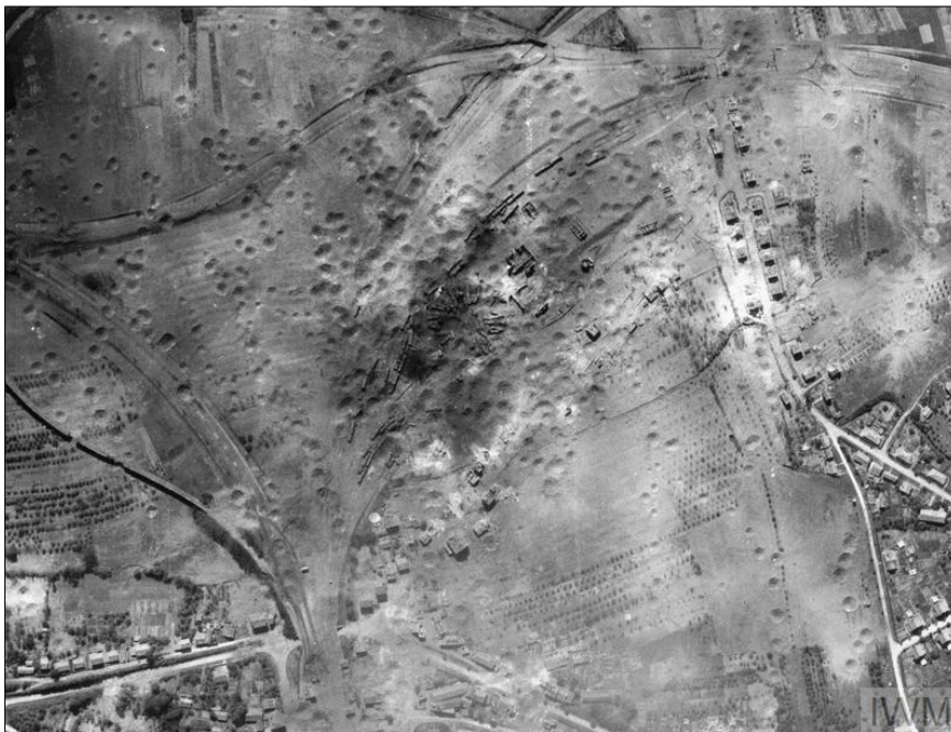
Figure 3 - Photographie verticale de reconnaissance aérienne, prise de 28,000 pieds (8,5 km), des locomotives et du garage détruits à Culmont-Chalindrey, France, après un raid du groupe Avro-Lancaster n°5 dans la nuit du 12 au 13 juillet 1944
