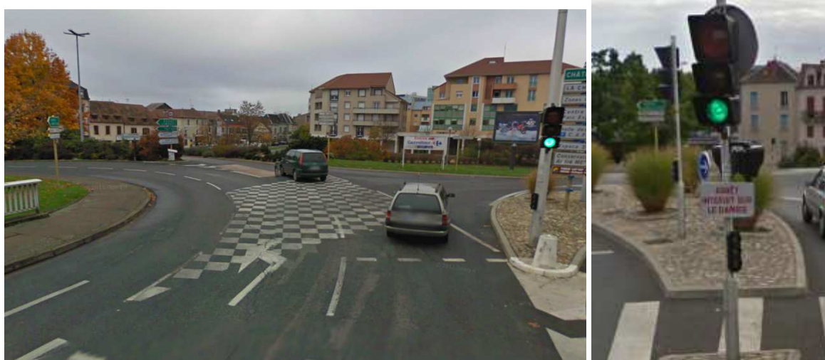
Figure 33 : Système de damier sur le pont St Jacques à Montluçon Source : Google view
