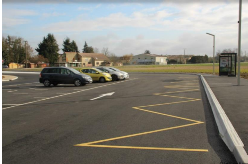
Figure 24 : Aire de covoiturage de Pézarches (Seine-et-Marne) Source : Le Pays Briard
