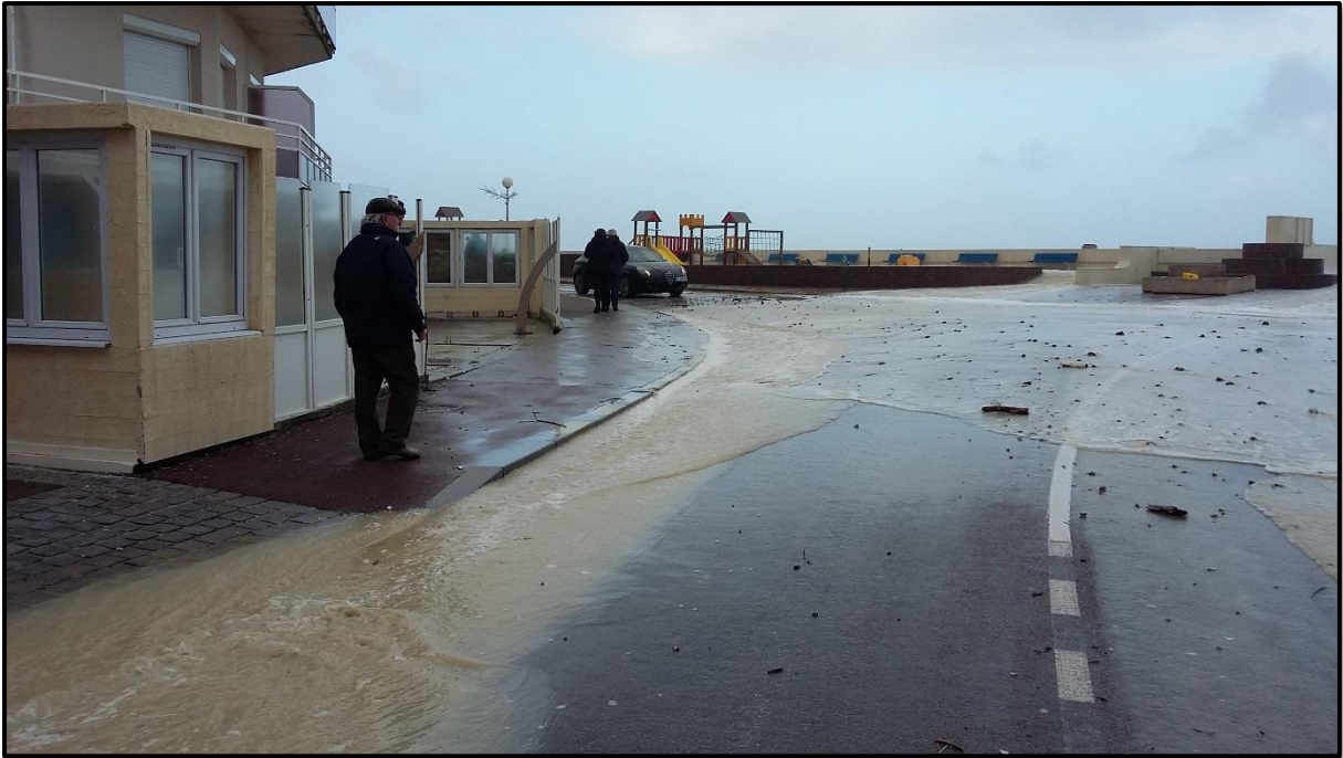
Inondation de la rue du front de mer lors de la tempête Eleanor 2, DDTM76, 2018.
