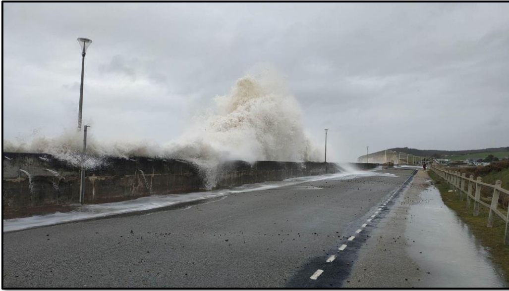
Fig. 65 : Inondation de la route de la mer lors de la submersion du 9 février 2020, DDTM76.
