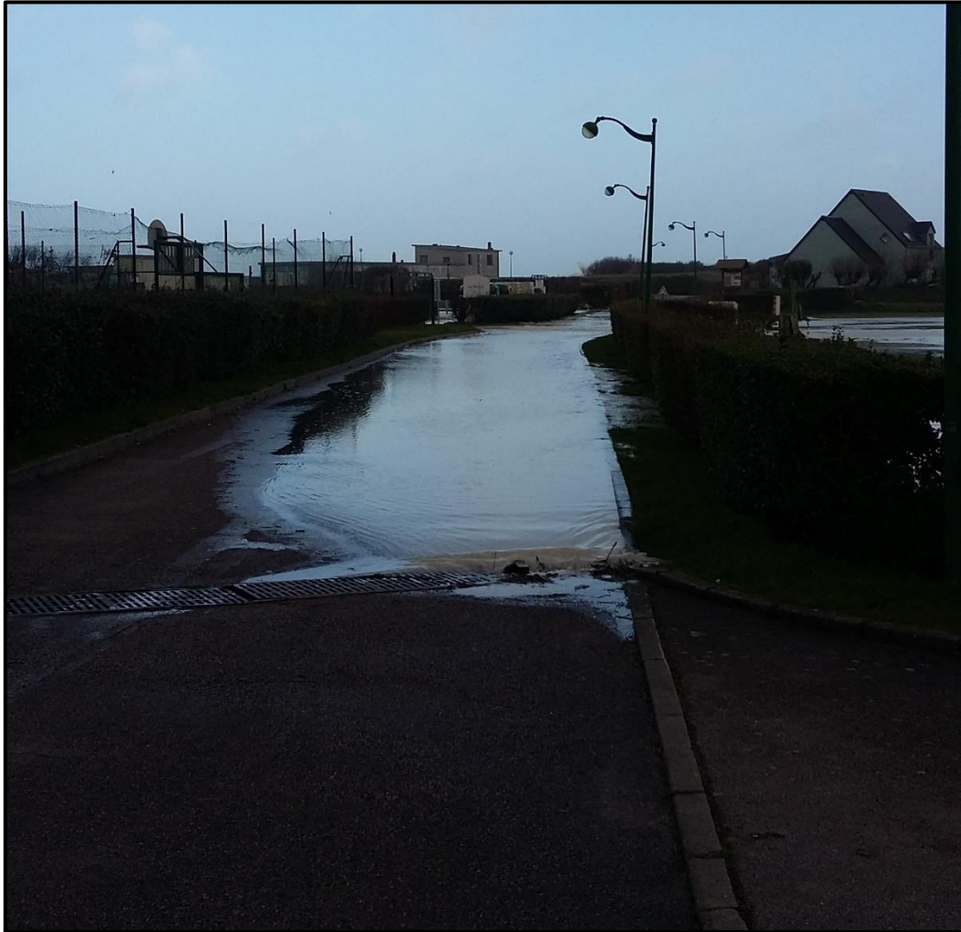
Inondation du chemin du camping lors de la tempête Eleanor, DDTM76, 2018.
