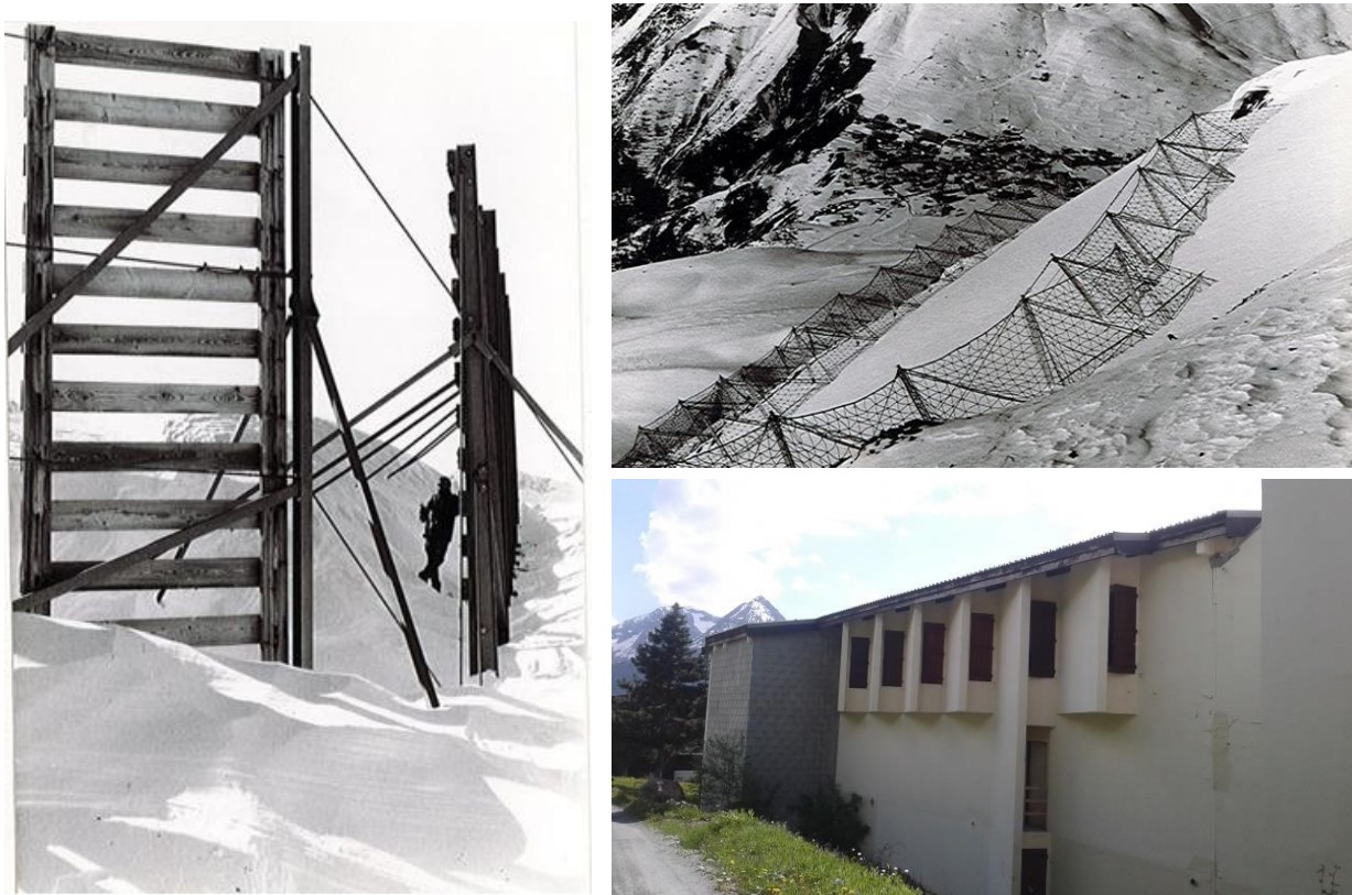
Figure 12 : de gauche à droite et de haut en bas : barrière à neige sur la montagne du Rachas (archives ONF-RTM, 1976), filets paravalanches, combe du Diable (archives ONF-RTM, 1976), conceptions intrinsèques paravalanches dans la station (archives ONF-RTM, 2018).
