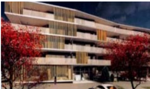
Projet MV Résidence, 45 logements
