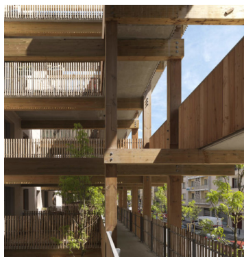
Edouard François Architecte - Coursives
