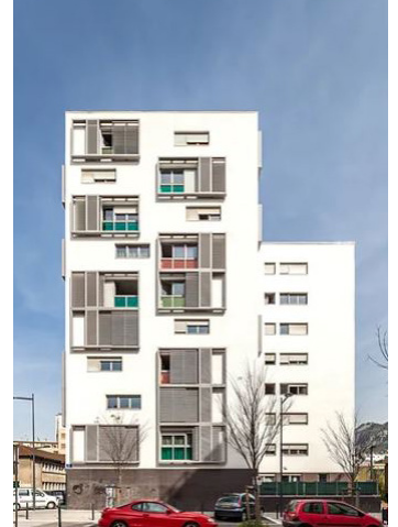
Béranger Gerbier Architecte
