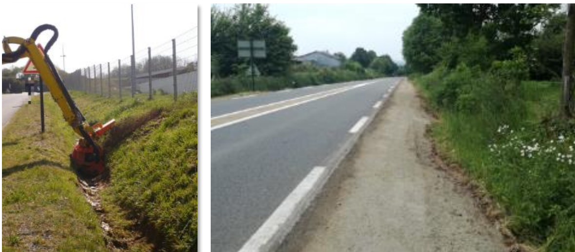
Figure 68 : curage par autocureuse (à gauche) et illustration d'un dérasement dissocié du curage (à droite) (MORIN F., BIZET V., 2020 (pages 19 et 21))
