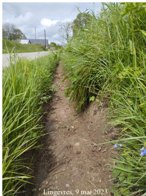
Figure 66 : curage d'un fossé réalisé avec un godet trapézoïdal (C. GAMBU, 2023)
