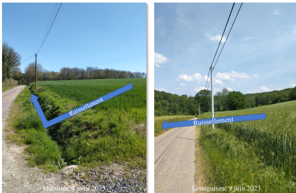
Figure 61 : différentes prises en charge du ruissellement par le réseau routier dans le cas des routes insérées (C. GAMBU, 2023)
