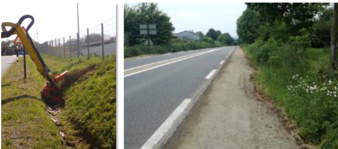
Figure 68 : curage par autocureuse (à gauche) et illustration d'un dérasement dissocié du curage (à droite) (MORIN F., BIZET V., 2020 (pages 19 et 21))
