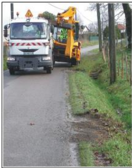
Figure 65 : réalisation de saignées pour évacuer l'eau de la route vers le fossé (F. MORIN et V. BIZET, 2020 (page 16))
