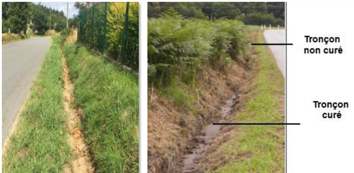
Figure 67 : curage par la méthode du tiers inférieur (à gauche) et curage en alternance (à droite) (MORIN F., BIZET V., 2020 (pages 8 et 9))
