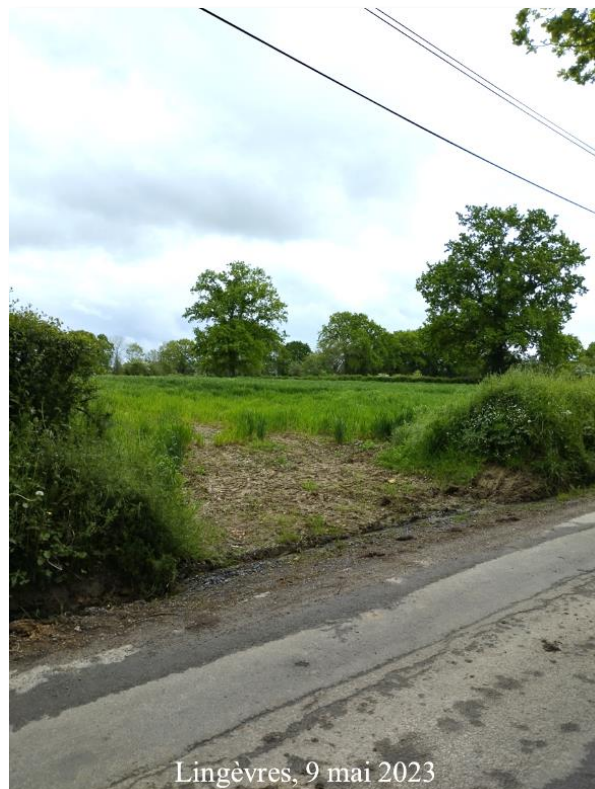
Figure 63 : malgré l'entrée de champ, présence de talus au bord d'une route qui empêchent le ruissellement d'aller sur le réseau routier (C. GAMBU, 2023)
