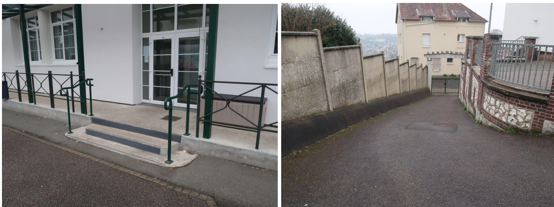
Fig. 23 : Photographies de l'état existant de la cour d'école Bernanos - à gauche : escalier devant l'entrée principale de l'école - à droite : pente forte donnant accès à la rue - Arc en Terre (document interne) - Mars 2023
