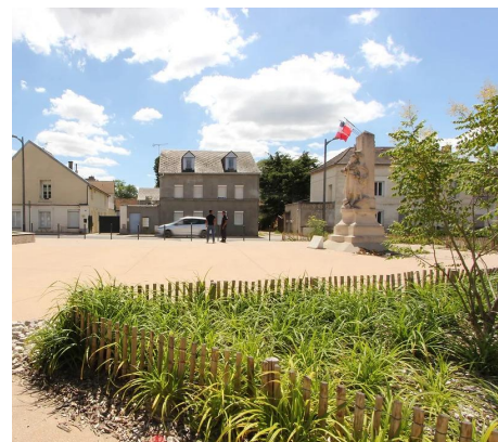
Fig. 28 : Photographie du projet de l'aménagement de la rue du Général de Gaulle à Pont-de-l'Arche (27) - AET 2022 (document interne)
