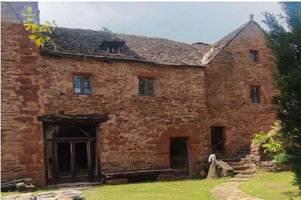
Figure 32. Tour de Puffepeyre et le corps de logis adjacent avec un coup de sabre, coté sud-est, cliché Kseniia MARIANINA
