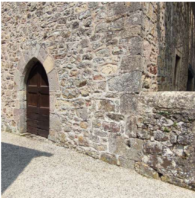
Figure 24. Château d'Is, l'emplacement d'une tour disparue, cliché Clovis DENOUAL
