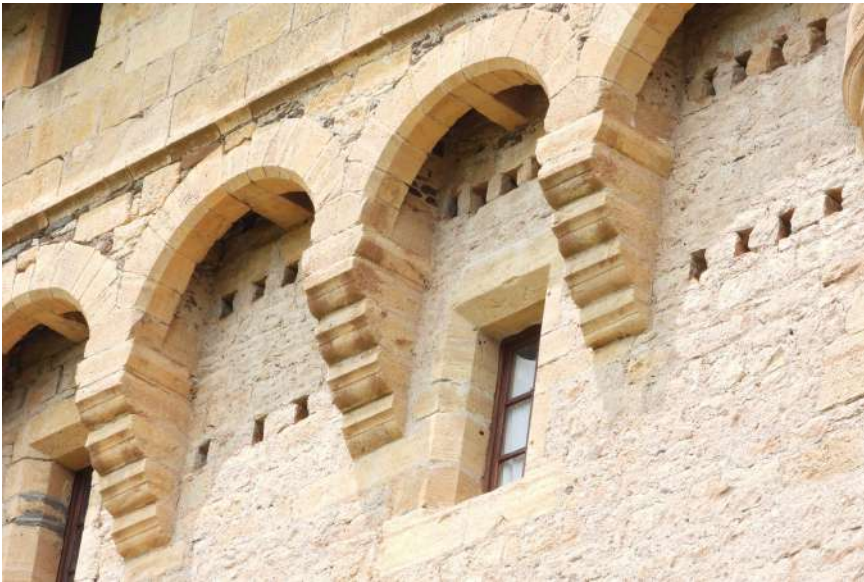
Figure 34. Château de Masse, les mâchicoulis, cliché Clovis DENOUAL
