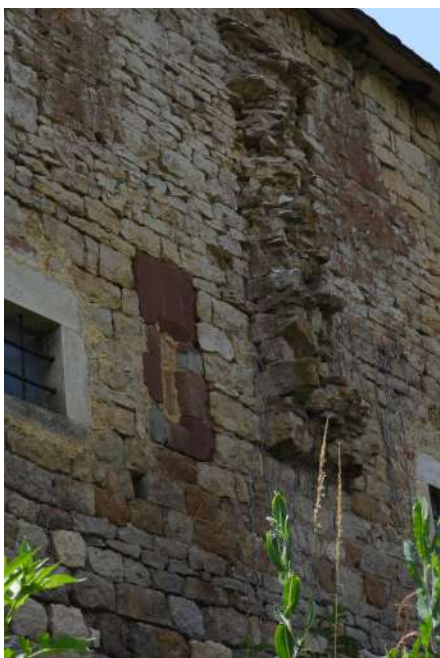
Figure 37. Grange de la Séveyrac, grange-étable, arrachement des contreforts, cliché Clovis DENOUAL
