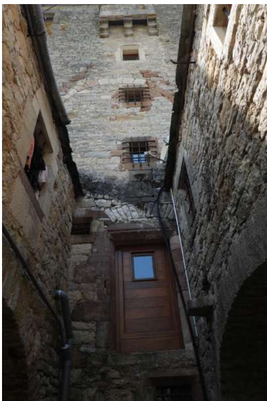
Figure 36. Grange de la Séveyrac, façade est, cliché Clovis DENOUAL
