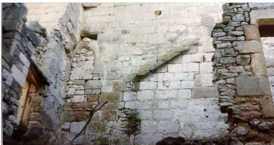
Figure 60. Photo du mur B3 avant des travaux de restauration en 1990, photo DRAC Occitanie
