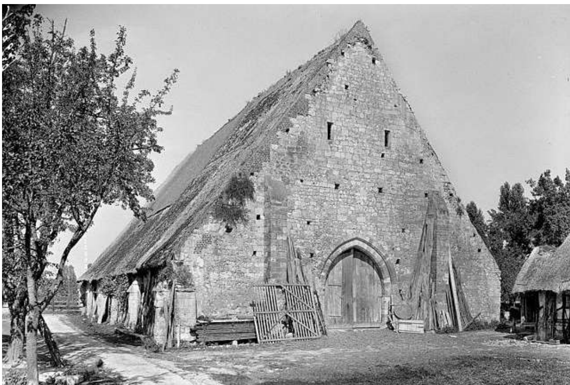
Figure 49. Les trous de boulins et les ouvertures d'aération sur la façade de grange aux dîmes à Heurteauville, source : Ministère de la Culture (France), Médiathèque du patrimoine et de la photographie
