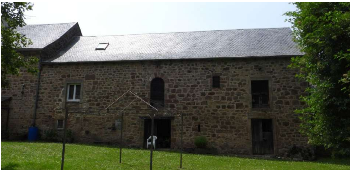
Figure 25. Château d'Is, bâtiment agricole, cliché Clovis DENOUAL
