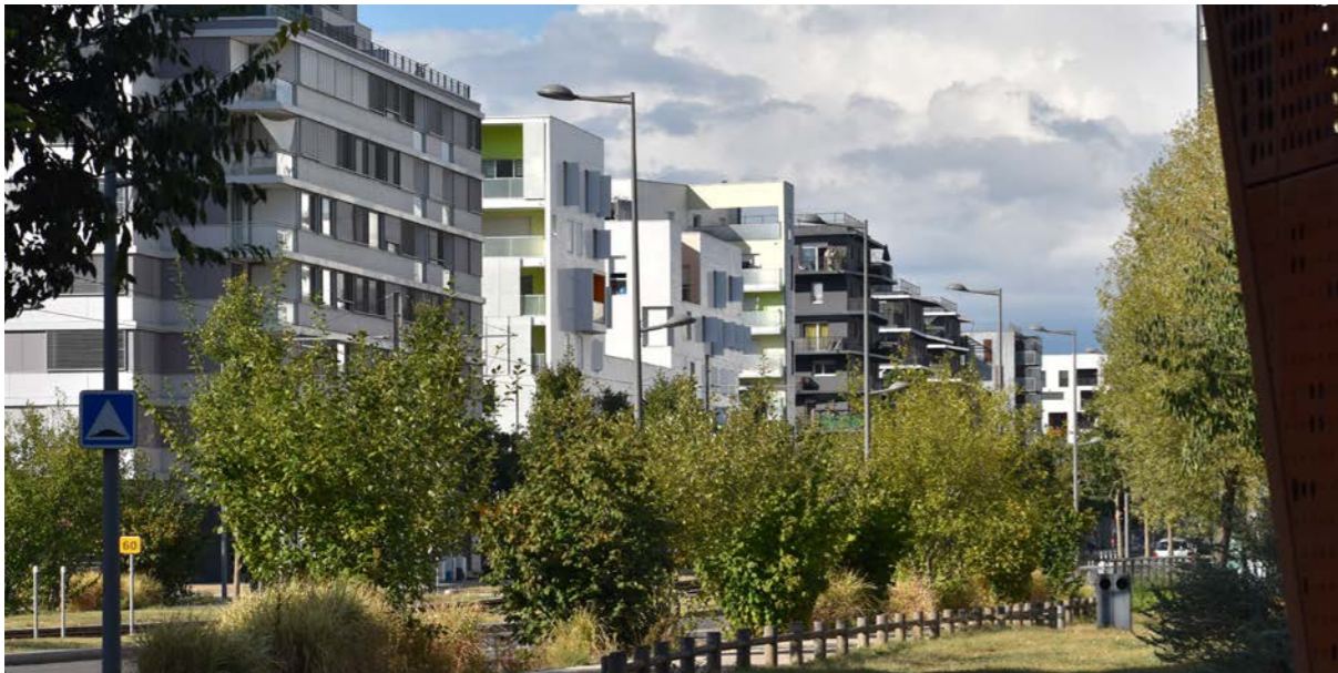
Fig. 05 : Vue de l'éco-quartier Ginko depuis la frontière des Aubiers, 2022 Photo personnelle
