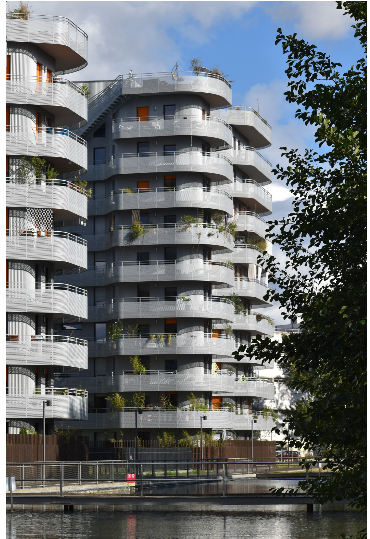
Fig. 27 : Les immeubles rue des Lendemains, 2022, Ginko Photo personnelle
