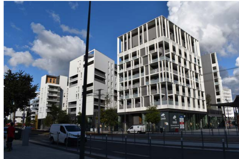
Fig. 24 : Les immeubles sur le cours du Québec, 2022, Ginko Photo personnelle
