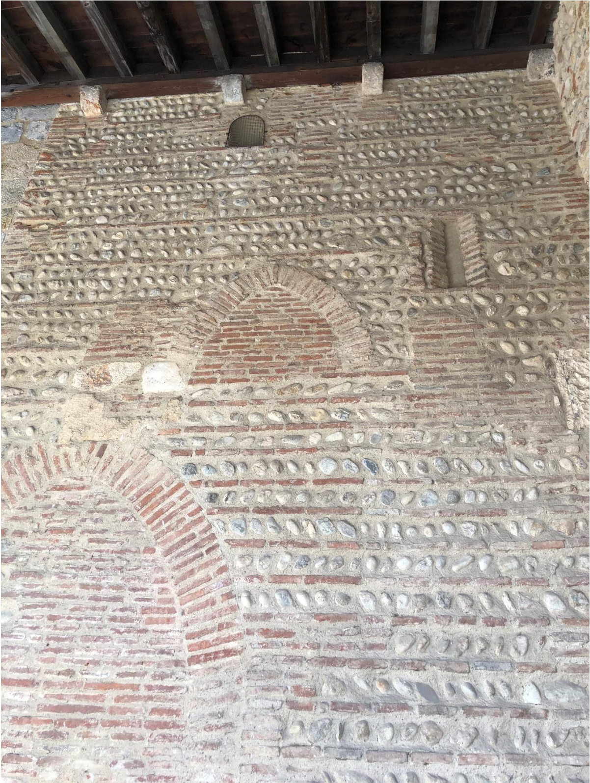
Figure 61 : Mur sous le portique d'entrée, cliché N. Roques
