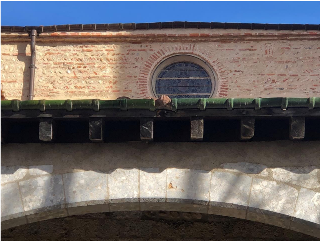
Figure 63 : Détails du portique et oculus
