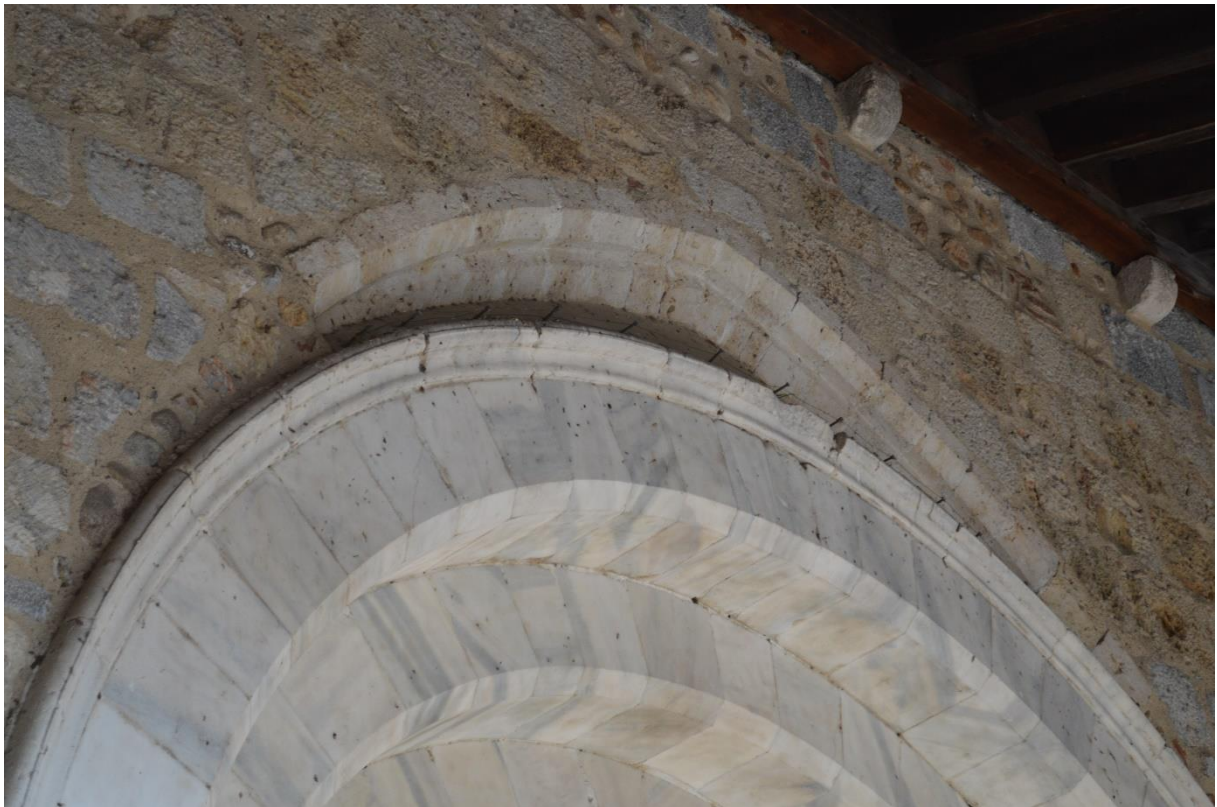
Figure 12 : Détail du portail actuel, surmonté d'un ancien portail en arc brisé
