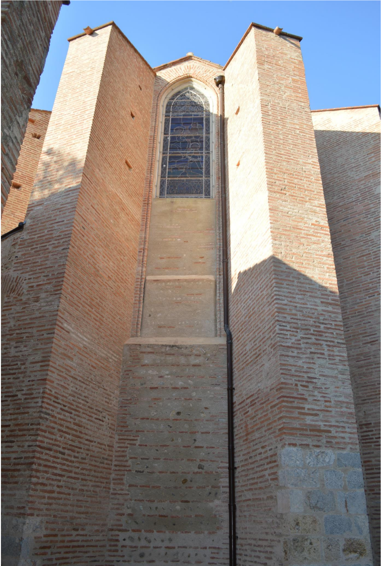
Figure 70 : Chevet de l'église, cliché C. de Barrau
