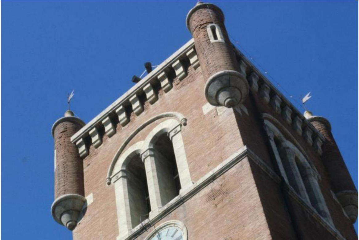
Figure 25 : Détail du clocher et de ses tourelles
