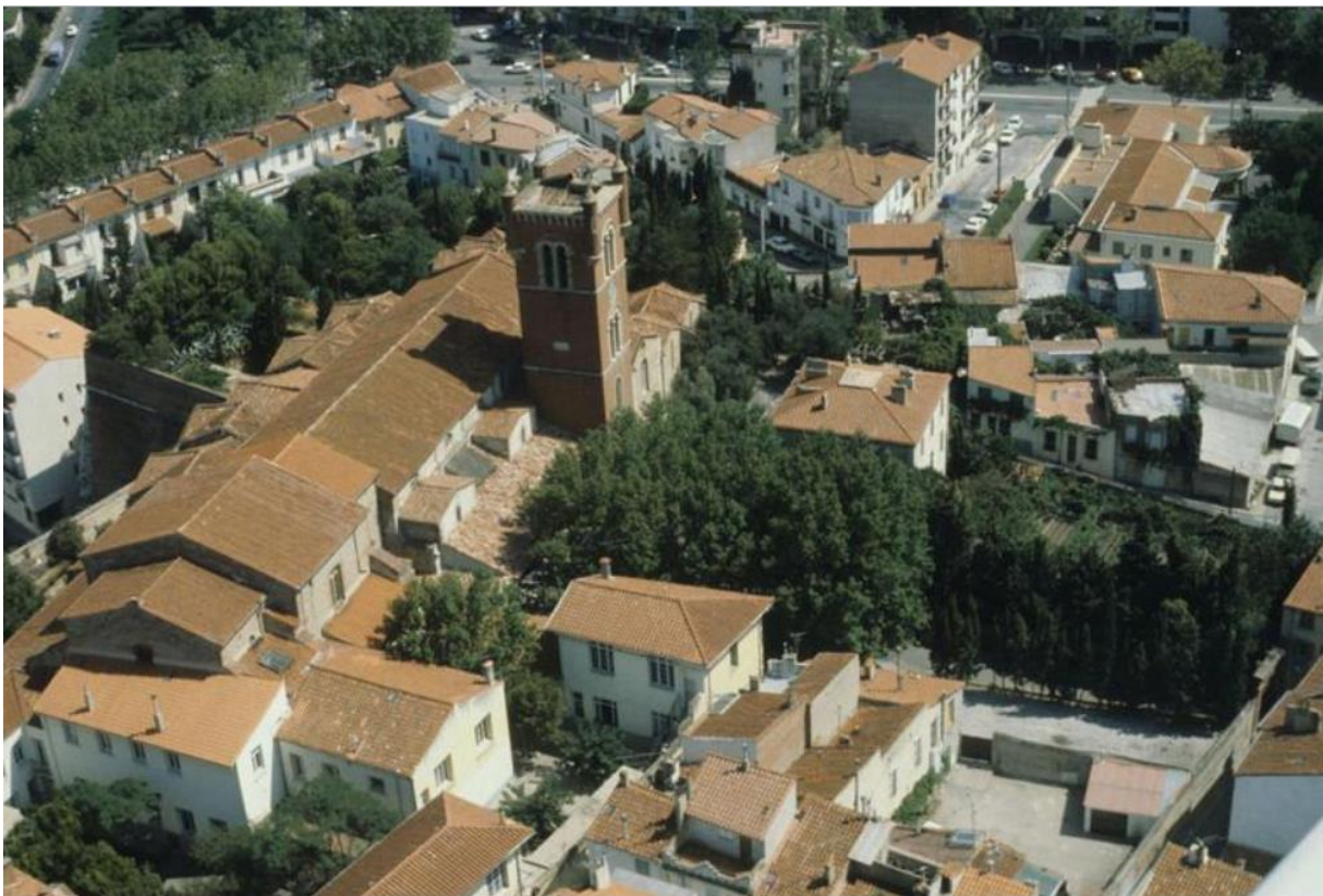
Figure 40 : Vue aérienne sur l'église Saint-Jacques
