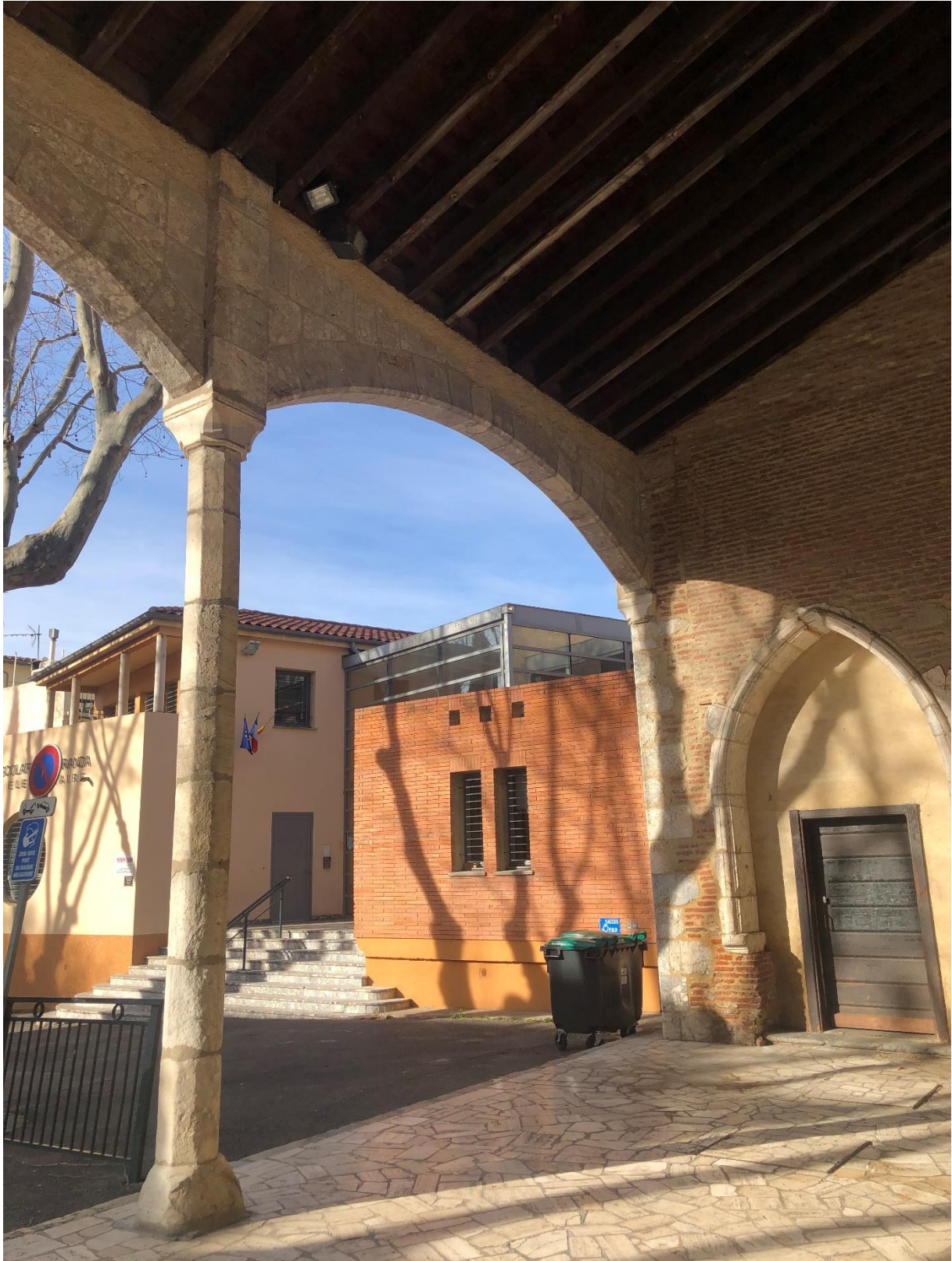
Figure 65 : Portique vu de dessous et enfeu, cliché N. Roques
