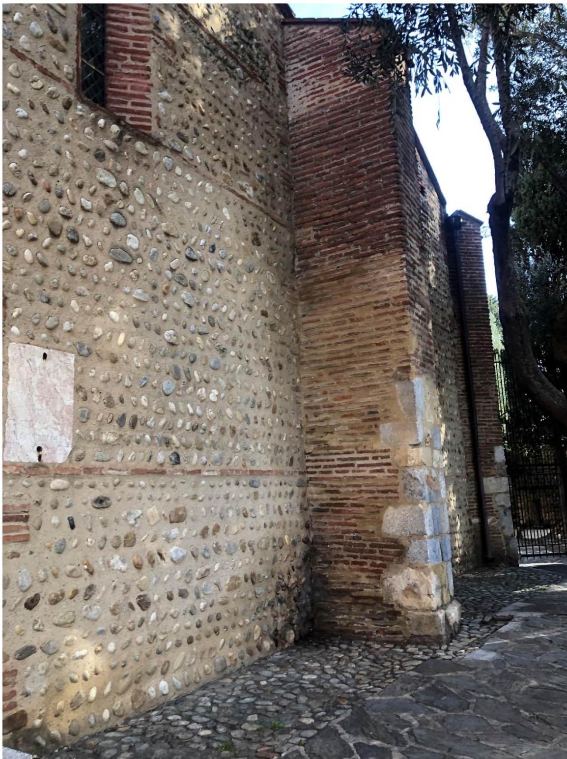
Figure 68 : Détail du mur de la chapelle des tisserands avec contreforts, cliché N. Roques
