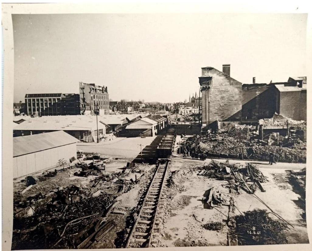
**Photographie 15 :** Photographie du photographe industriel H. Baranger montrant la circulation des wagonnets destinés au déblaiement des décombres. À gauche, on peut voir les baraquements-magasins de la place Jeanne-Hachette tandis qu'à droite on aperçoit ce qui reste de l'hôtel de ville, c'est-à-dire essentiellement la façade. Cette photo a certainement été prise entre 1940 et 1942 (Collection des archives municipales de Beauvais).
