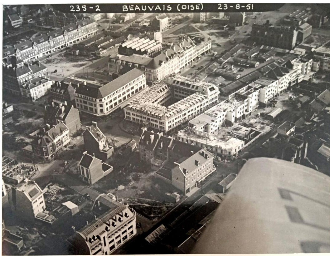
Photographie 18 : Photographie aérienne d'un photographe inconnu prise le 28 août 1951. Elle montre les nouveaux immeubles en construction de la Place Jeanne-Hachette. On peut voir également les treize baraquements-magasins encore présents au milieu de la place (Source : Collection des archives municipales de Beauvais).
