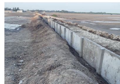
Digue de protection en cours de construction
