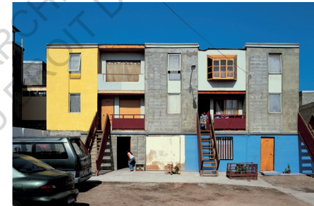
Projet Quinta Monroy : Après l'intervention des habitants
