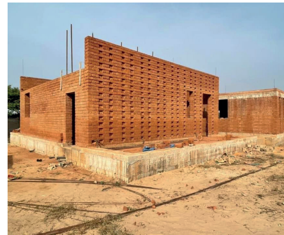
Worofila : Villa R+1 en cours de construction à Thies
