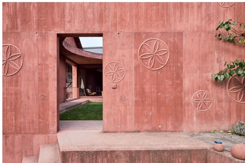
Fig 55 L'atelier Bardill, l'architecture d'Olgianti communiquant uniquement avec des éléments architectoniques (le motif répété, la porte, le matériaux brut, la figure de la maison dépouillée de son toit ...), Suisse, 2007
