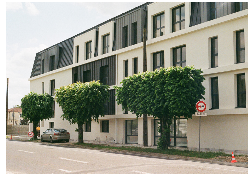
Fig 38 Des immeubles de «logements étudiants» en construction le long de l'avenue de Nantes, Niort, photographie personnelle, 2023
