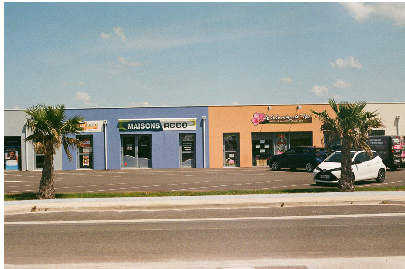
Fig 40 Une «zone d'activité» fraîchement sortie de terre au sud de Niort, photographie personnelle, 2023
