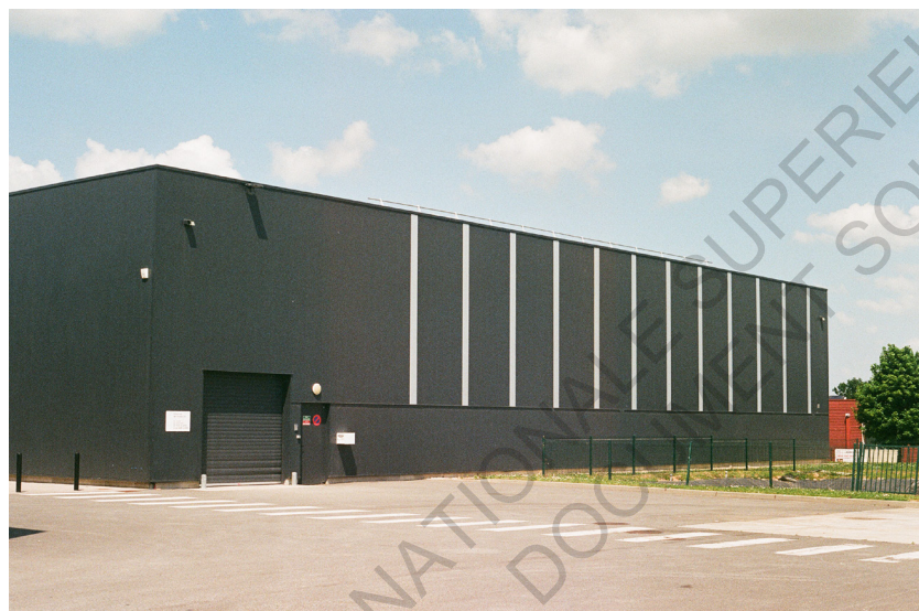
Fig 41 Les constructions se resument à des hangars en structure métallique et bardage noir, parfait pour créer des espace en surchauffent l'été, pas de soucis ces hangars sont équipé de climatisation, photographie personnelle, 2023
