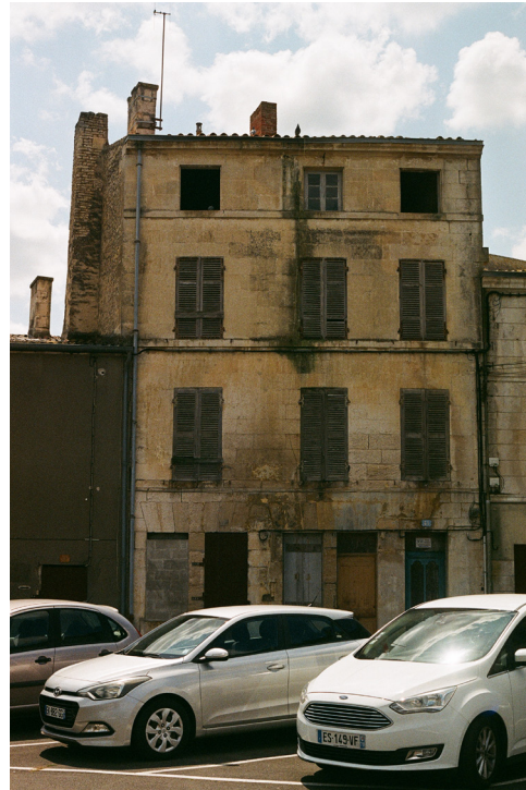
Fig 36 Un immeuble abandonné dans le centre de Niort, photographie personnelle, Niort, 2023
