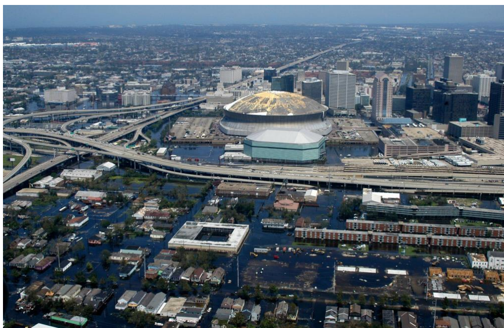
Illustration 5 : Vue aérienne de la Nouvelle-Orléans prise par un hélicoptère de la marine américaine le 31 Août 2005. On y voit l'inondation provoquée par la rupture des digues, ainsi que le SuperDome en mauvais état (au centre de l'image) où de nombreux habitants de la Nouvelle-Orléans se sont réfugiés.
