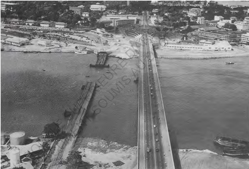
Les interventions symboliques des indépendances. La construction du nouveau pont Félix Houphouët Boigny pendant que l'ancien pont levis se fait démolir. Source: Ibid
