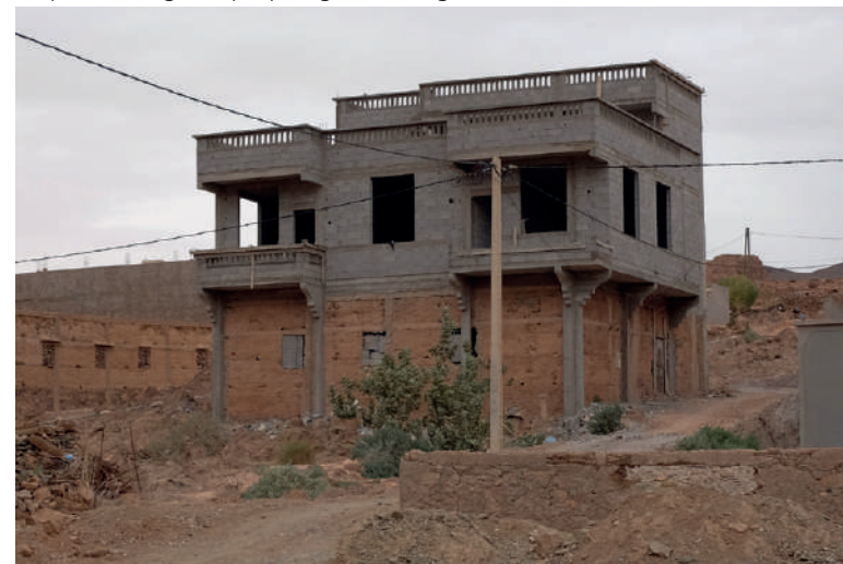
Le pisé ici est employé juste pour le niveau de plain-pied, le parpaing utilisé à l'étage permet de réaliser des géométries plus complexes avec des balcons, des portes à faux etc. Talmazighte ©N.C.
