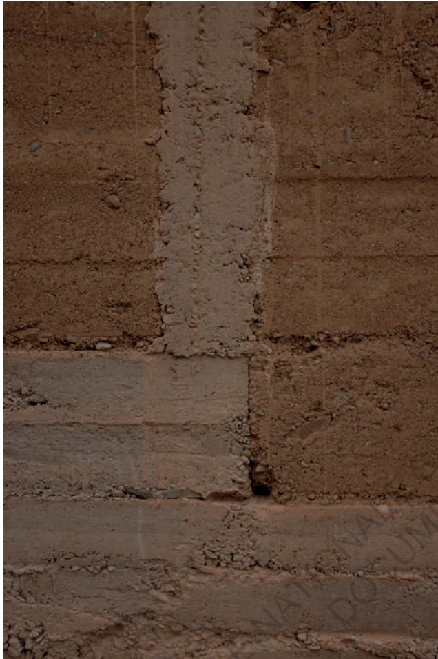
Jonction soubassement, poteau et pisé. La trace en lanière est commune aux deux techniques réalisées toutes les deux en coffrage. Talmazighte ©N.C.
