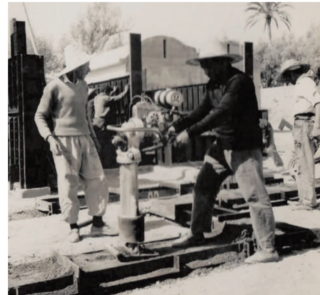
Mise en œuvre de la préfabrication du pisé à Berkane. (© Fonds Alain Masson). Archives ULB La Cambre
