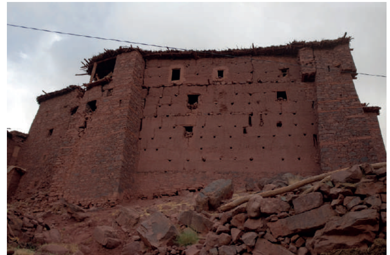
Grenier collectif maçonné en pisé pour les façades et en pierre dans les angles. Magdaz. © N.C.
