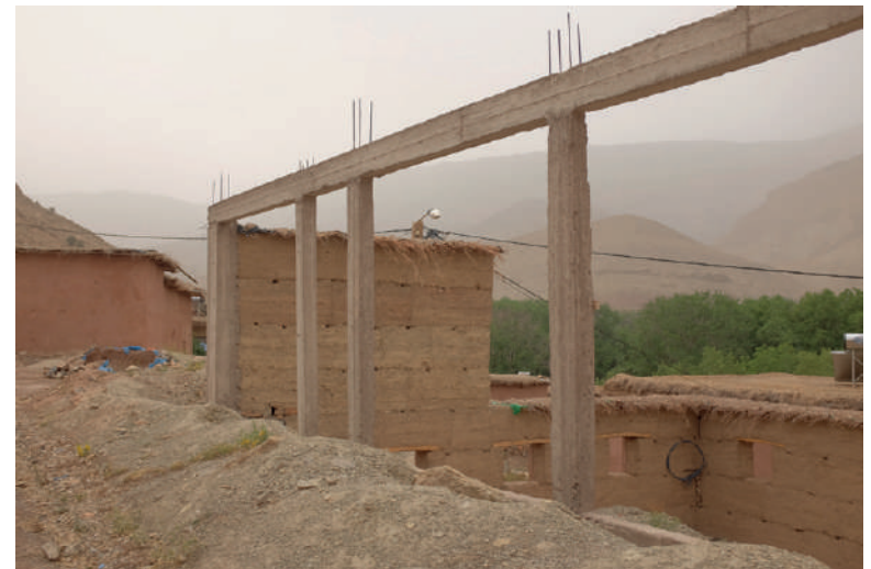
Chantier dans la vallée des Aït Bouguemez © N.C.
