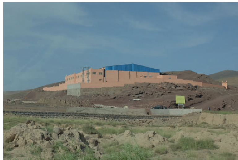
Frigos à pommes observés dans le Haut-Atlas. En haut dans la vallée des Aït Bouguemez et en bas vers M'semrir après les gorges du Dadès. © N.C.
