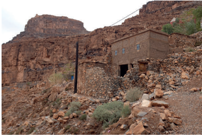
Extension en parpaing sur une ancienne maison en pierre, prenant certainement appui sur les fondations en pierre existantes. Amtoudi ©N.C.
