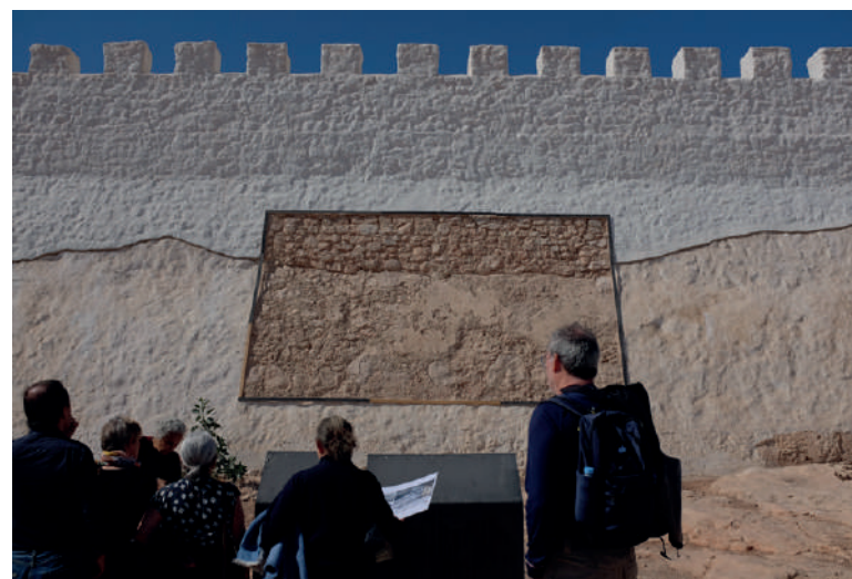
Le « cerne de la douleur » en liseret et un encadrement montrant les maçonneries des deux parties de la muraille sous la chaux © N.C.
