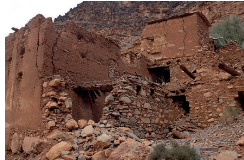
Ruines d'une ancienne habitation près de la rivière. Certains murs sont en pisé et d'autres en pierre maçonnerie au mortier de terre. Non entretenues, ces constructions se défont et retournent à la terre. Amtoudi ©N.C.
