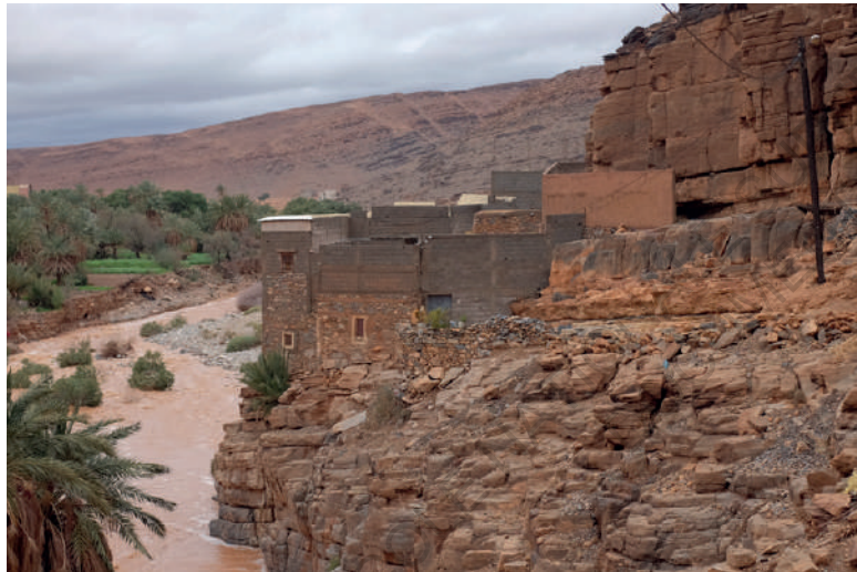
Parties basses du bâtiment en pierre, chaîné au béton armé, et parties supérieures en parpaing. Amtoudi ©N.C.
