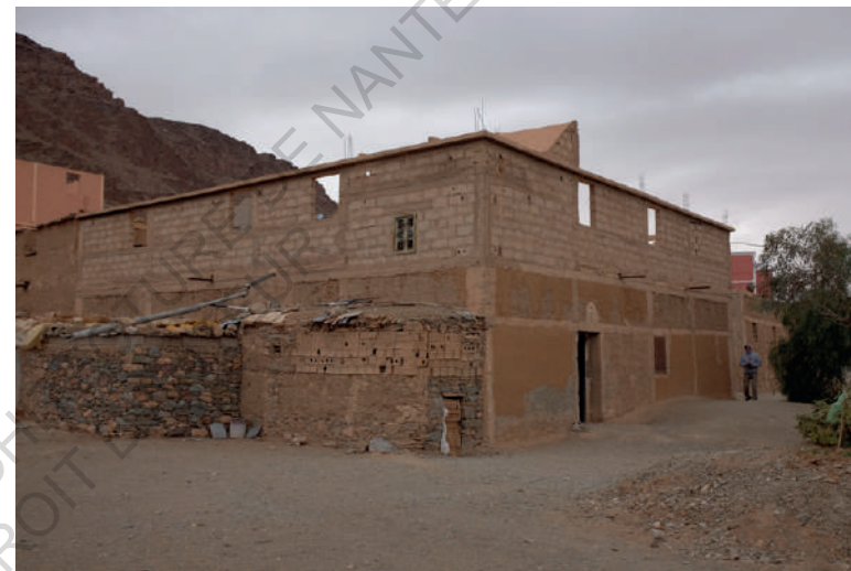
Chaînage en béton armé, mur en pisé, parfois soubassement en pierre, étage en parpaing. Talmazighte ©N.C.
