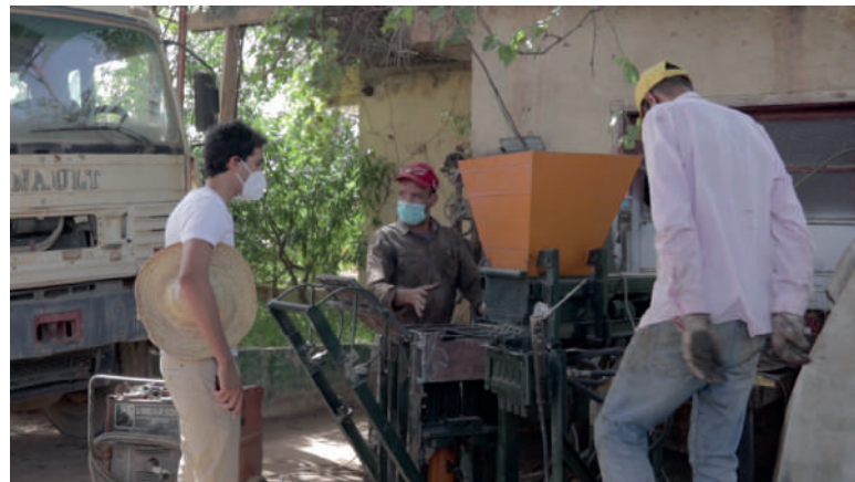
Mise en place de la presse hydraulique pour la création des BTC. Août 2021. ©ateliergemine
