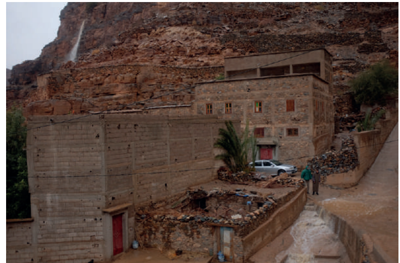
Constructions édifiées sur plusieurs étages; partie basse en pierre ; étages supérieurs en parpaing. Parfois entièrement en parpaing ©N.C.
