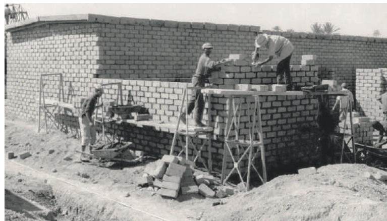
Chantier BTC, unité 3, Daoudiate. Marrakech. (© Fonds Alain Masson).
