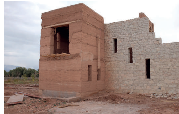
Extérieur d'une des maisons en chantier, mur réalisé en pisé et pierre © N.C.
