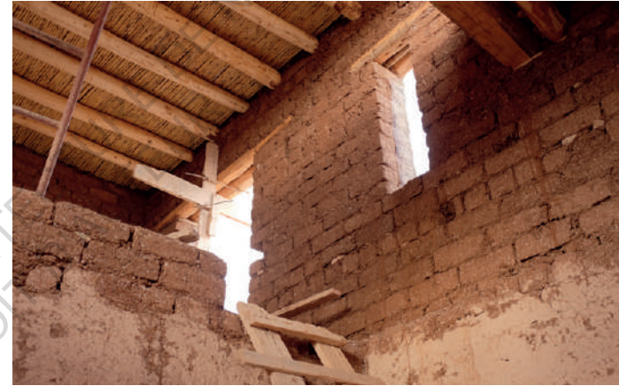
Intérieur d'une maison en chantier, mur réalisé en brique d'adobe © N.C.
