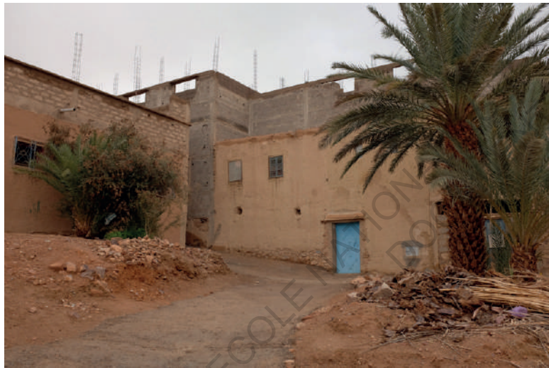
Le Ksar est aujourd'hui habité et de nouvelles constructions/extensions sont bâties sur l'existant ©N.C.
