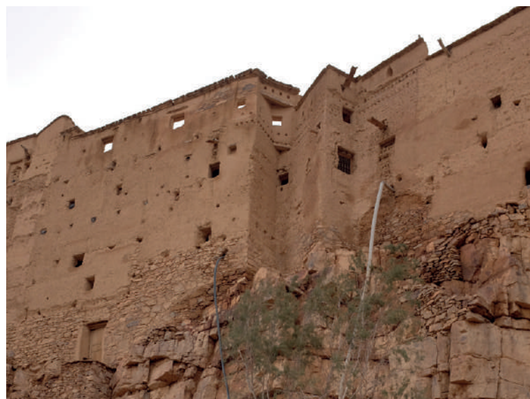
Adaptation de la façade de l'Agadir Ouzrou à la roche sur laquelle il s'implante ©N.C.
