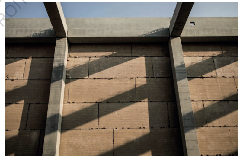
Maison des plantes de Ricola en pisé préfabriqué. Réalisé par Martin Rauch_Herzog & De Meuron ©Daniel Lüthi
