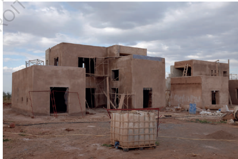
Maison en cours de chantier, réalisée par l'entreprise Argilex © N.C.
