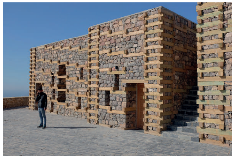
Le bâtiment d'accueil pour visiteurs en contrebas de la citadelle. Bois et pierre © N.C.
