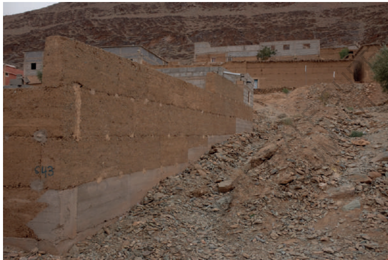
Le béton est utilisé cette fois-ci uniquement en fondation étagée pour s'adapter à la pente (construit après la révision du code de l'urbanisme?). Talmazighte ©N.C.
