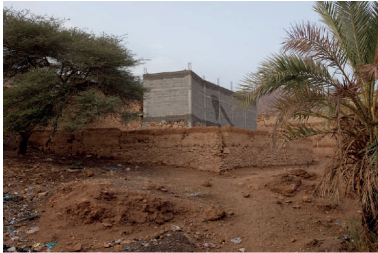
Emergence en parpaing au milieu de la pierre et de la terre. Tissint ©N.C.
