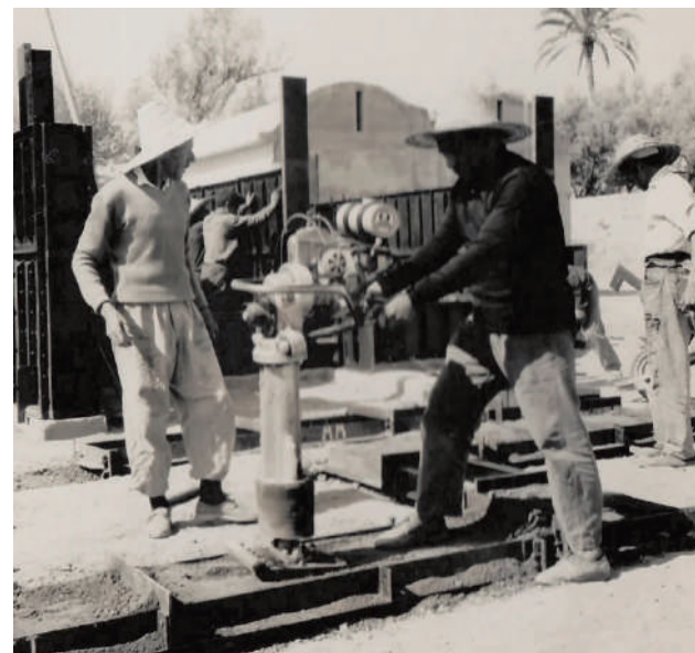
Mise en œuvre de la préfabrication du pisé à Berkane. (© Fonds Alain Masson). Archives ULB La Cambre
