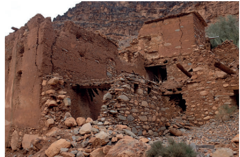
Ruines d'une ancienne habitation près de la rivière. Certains murs sont en pisé et d'autres en pierre maçonnée au mortier de terre. Non entretenues, ces constructions se défont et retournent à la terre. Amtoudi ©N.C.
