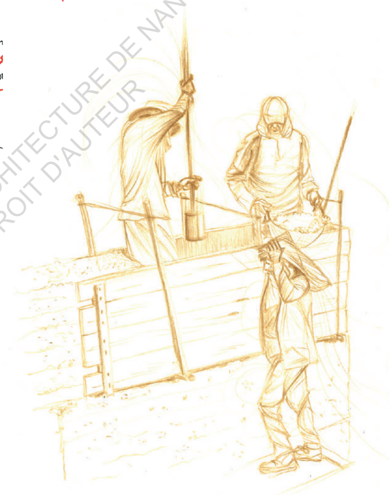
Maçons à l'oeuvre sur une levée de pisé. Vallée des Aït Bouguemez © N.C. Avril 2023
