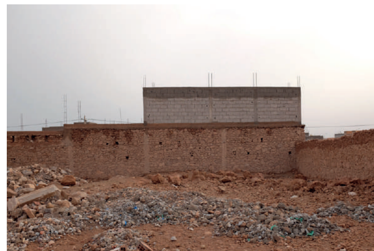
Emergence en parpaing au milieu de la pierre et de la terre. Tissint ©N.C.
