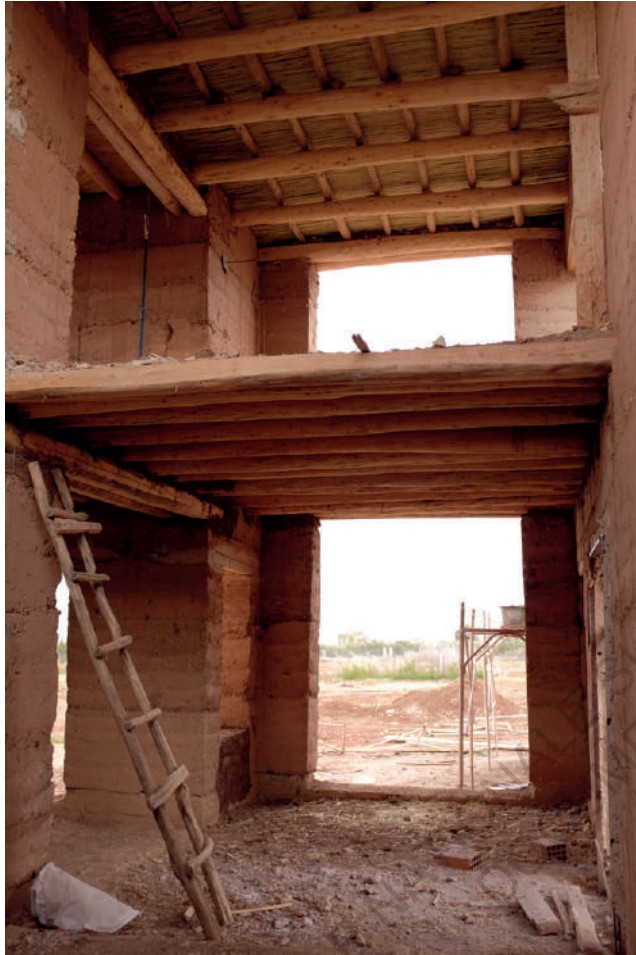
Volume intérieur d'une maison © N.C.
