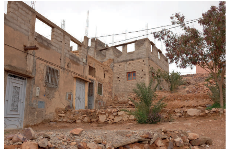
Le Ksar est aujourd'hui habité et de nouvelles constructions/extensions sont bâties sur l'existant ©N.C.
