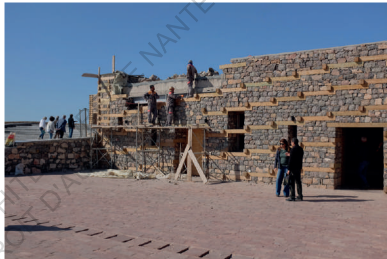
Réparation d'une portion de façade dévoilant la sous-structure en acier © N.C.
