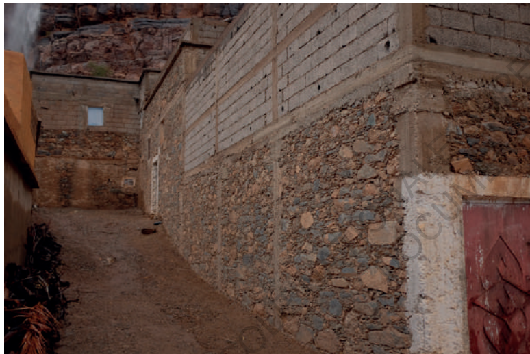
Constructions édifiées sur plusieurs étages; partie basse en pierre, étages supérieurs en parpaing ©N.C.
