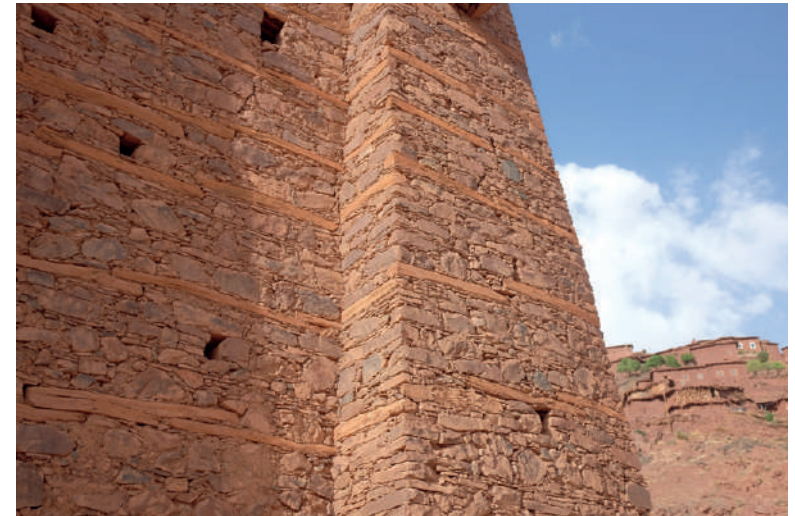
Angle d'un grenier à Magdaz © N.C.
