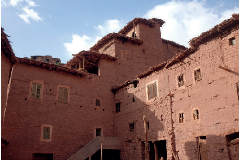
Construction à 5 niveaux à Magdaz © N.C.
