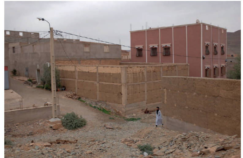
Autres exemples de construction avec parpaing en étage et chaînage + fondations en béton. Talmazighte ©N.C.
