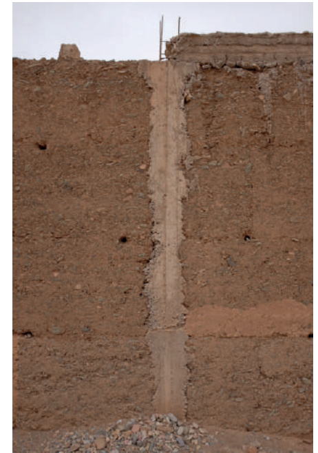
Détails de mise en oeuvre, la jonction entre le béton et le pisé doit faire l'objet d'un grand soin au risque de fragilisation du bâtiment à court terme (infiltration d'eau, gel etc. Talmazighte ©N.C.
