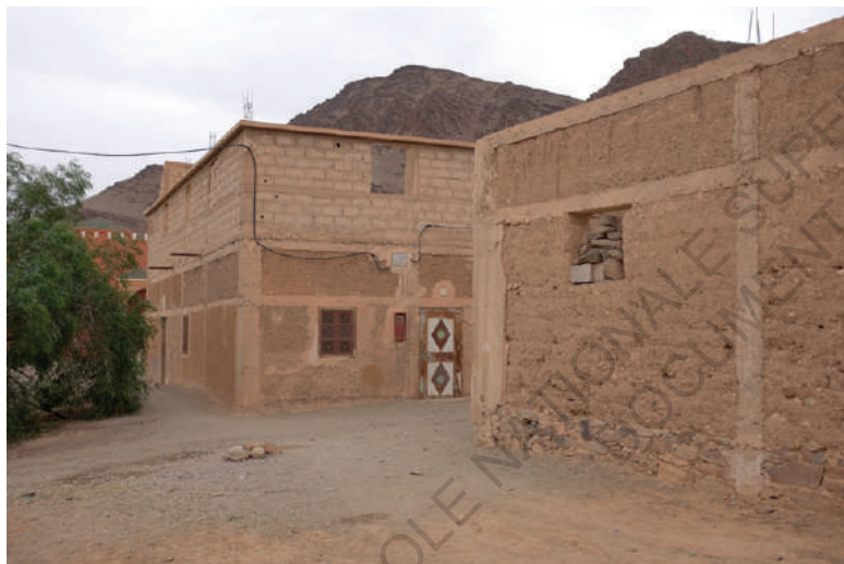
Chaînage en béton armé, mur en pisé, parfois soubassement en pierre, étage en parpaing. Talmazighte ©N.C.
