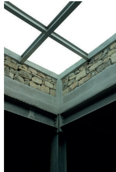
Intérieur des bâtiments d'accueil. Couplage d'une enveloppe en bois et en pierre et d'une structure de toiture en acier © N.C.
