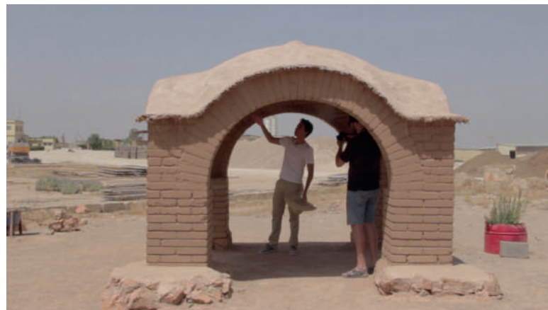
Courbure de la voûte nubienne. Août 2021 ©ateliergemine
