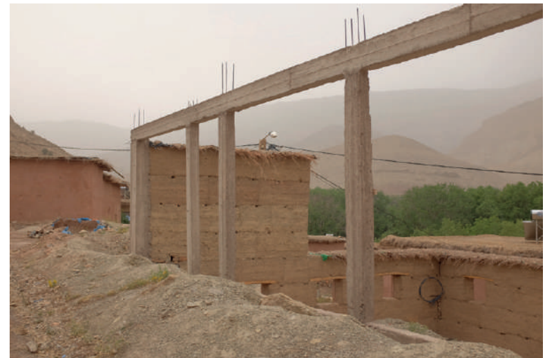
Chantier dans la vallée des Aït Bouguemez © N.C.
