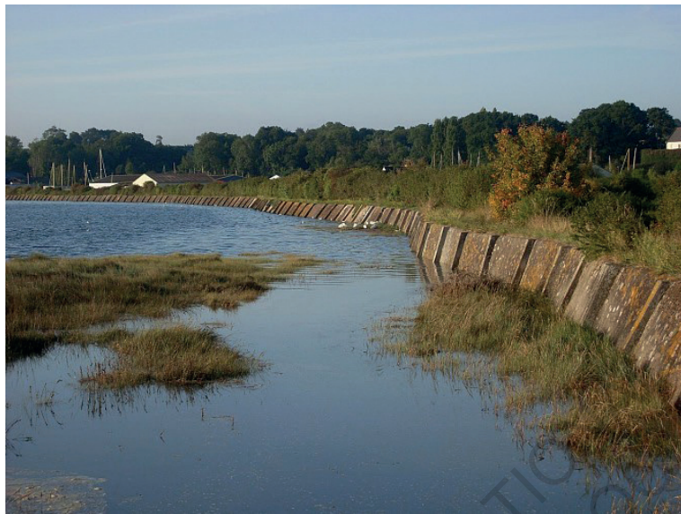
OT CEVA, La digue des moines, Saint-Jacut-de-la-mer, non datée, photographie
