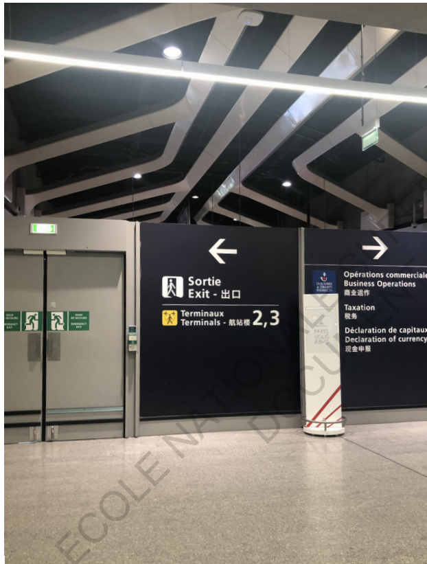
Fig 84: Niveau des arrivées, cloisons ajoutées pour gérer les flux, photo personnelle
