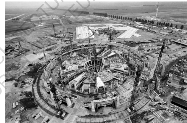
Fig 15: Construction de l'aéroport Paris-Charles de Gaulle, https://www.grand-roissy-tourisme.com/2022/02/14/histoire-de-la-creation-de-l-aeroport-charles-de-gaulle/
