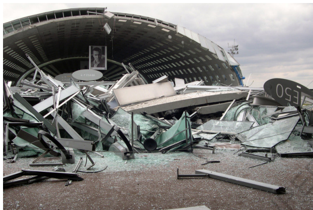
Fig 78: Effondrement de la salle d'embarquement du Terminal 2E, AFP
