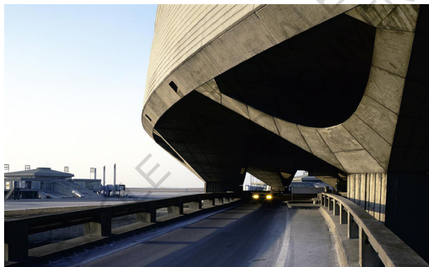
Fig 51: Le Terminal 1, ouvrage d'art, Paul Maurer
