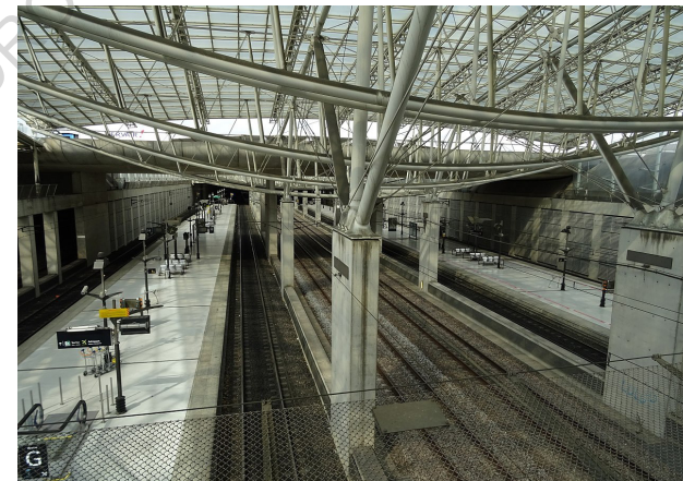
Fig 31: La gare Aéroport Charles de Gaulle 2 TGV, Remontées
