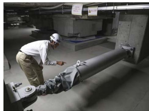
Parmi les dispositifs d'isolation parasismique, on peut voir les isolateurs «secs» en néoprène fretté qui vont absorber l'énergie cinétique en se déformant (ci-dessus à gauche) ou encore des amortisseurs viscoélastiques qui s'actionneront lors de l'apparition des accélérations sismiques.(ci-dessus à droite)
