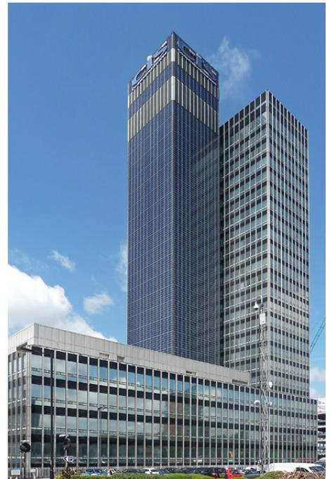
Ce bâtiment haut de 118m a été le sujet d'une grande réhabilitation en 2006. Les façades Est Sud et Ouest sont couvertes de 724.480 panneaux photovoltaïques faisant de cet immeuble le plus grand bâtiment «panneau solaire» d'Europe (3).
