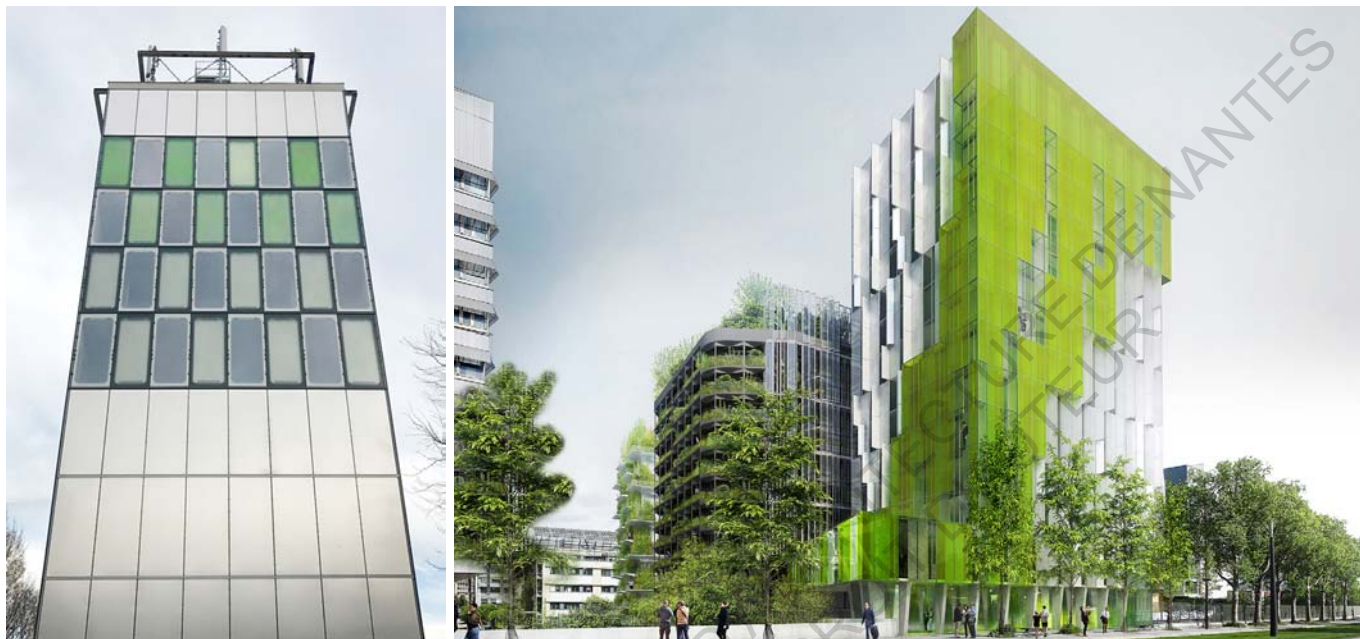
A gauche : Prototype sur la façade d'une tour du CSTB de Marne-La-Vallée, premier pas vers l'application à grande échelle ? A droite : Bâtiment lauréat de l'appel à projet «Réinventer Paris» qui présentera plusieurs centaines de mètres carrés de «biofaçades» dans le 13e arrondissement de la capitale. (Crédit : XTU Architects)
