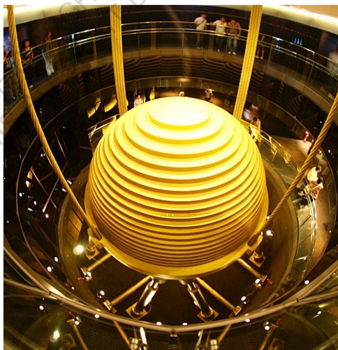
A gauche, le Taipei 101, haut de 509m, conçu par C.Y. Lee & Partners Architects, achevé en 2004. A droite, une photographie donnant l'échelle de l'oscillateur, en suspension sur une hauteur de 4 étages, maintenu à l'aide de larges câbles d'aciers et de vérins hydrauliques à sa base.
