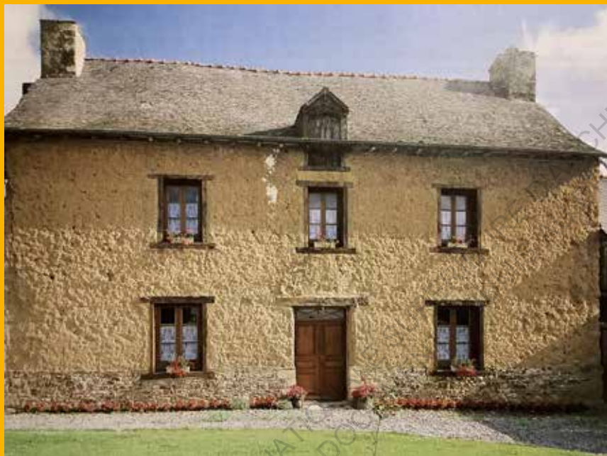
003 Maison en bauge - Saint-m'Hervon (Ille-et-Vilaine), in Armen n°5 octobre 1986 p31 ©René Le Thomas
