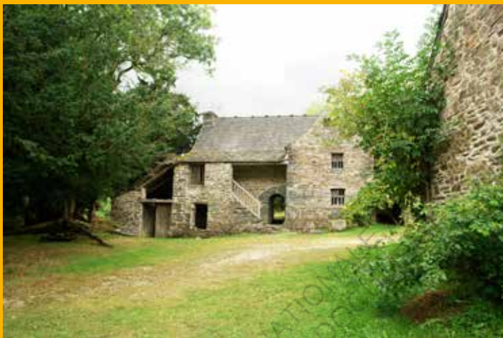
005 Maison Cornec, maison à étage et à apoteis (avancée) peu courante à cette époque - Saint Rivoal (Finistère), 1702
