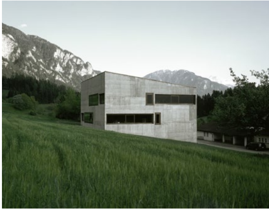
fig. 1 : Valerio Olgiati, ECOLÉ, Paspels (Suisse), 1998 - Élévation + photo extérieure - la pente de toiture suit celle du site - Quand on regarde la position des fenêtres, on se demande comment le tout peut tenir structurellement car rien ne se superpose
