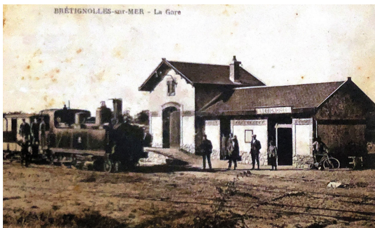
La gare de Brétignolles-Sur-Mer, 1925, Brétignolles-Sur-Mer, Sur les traces de son passé , 1999
