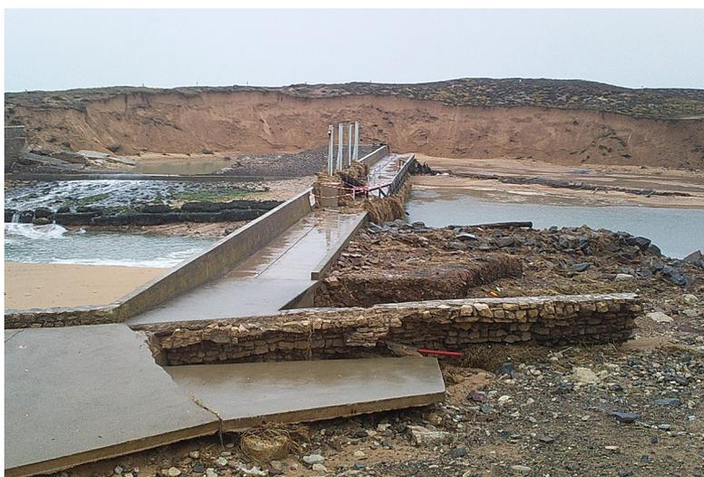
Photographie personnelle. À plus de 50 kilomètres de la Faute-Sur-Mer, Xynthia a endommagé les dunes de Brétignolles et a détruit sa digue protectrice en béton.
