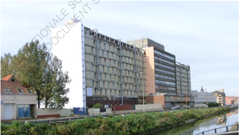
Fig 23 - Le centre hospitalier, quai du Commerce
