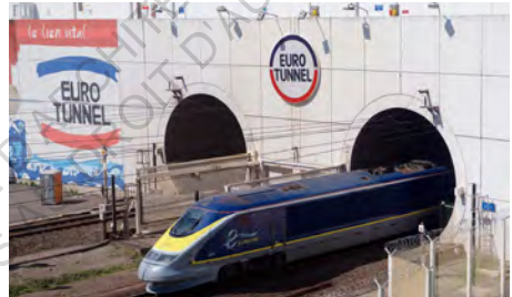
Fig 33 - Sortie d'un Eurostar du Tunnel
