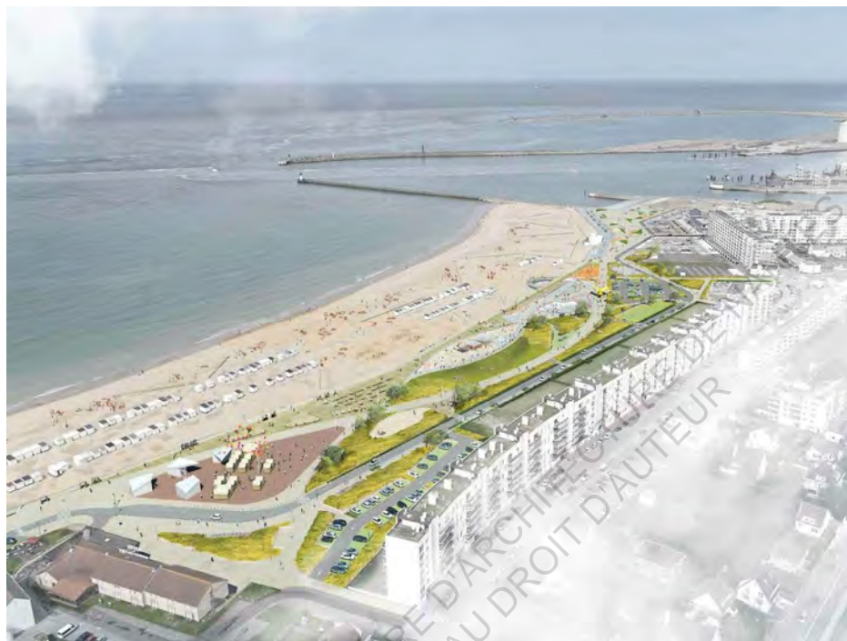
Fig 94- Le front de mer réhabilité
