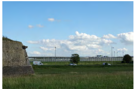
Fig 100- La proximité des voies d'accès au Tunnel
