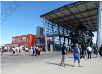
Fig 62- La nef provisoire (à droite ) et les locaux de la SPL ( à gauche )
