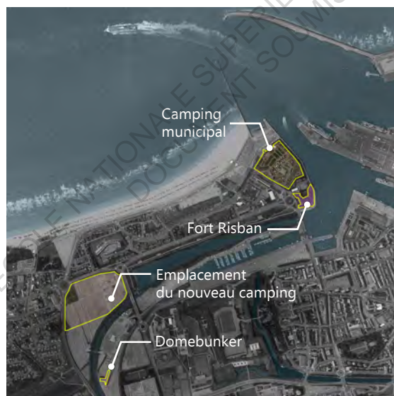
Fig 73- Vue aérienne de Calais avant les travaux de la phase 1
