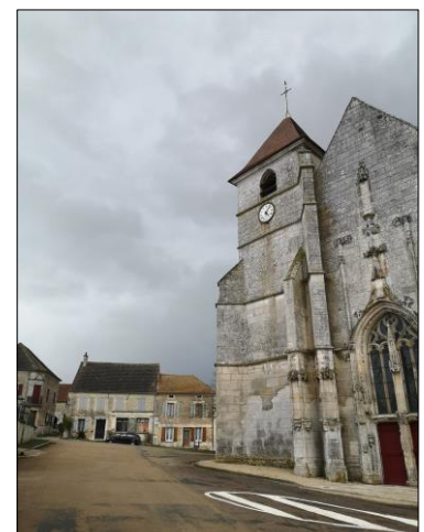
Fig 60 – Place de l'Eglise
