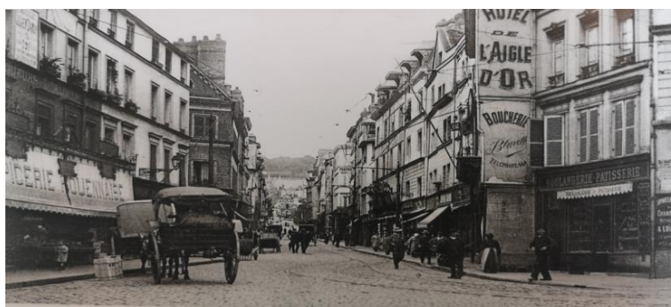
Fig 34 – Photographie de la rue Cauchoise à ROUEN
