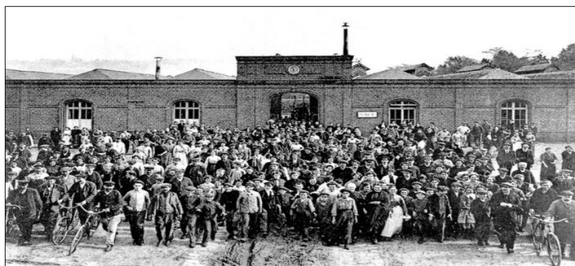
Fig 8 - Photographie de la sortie de l'Usine BERTEL
