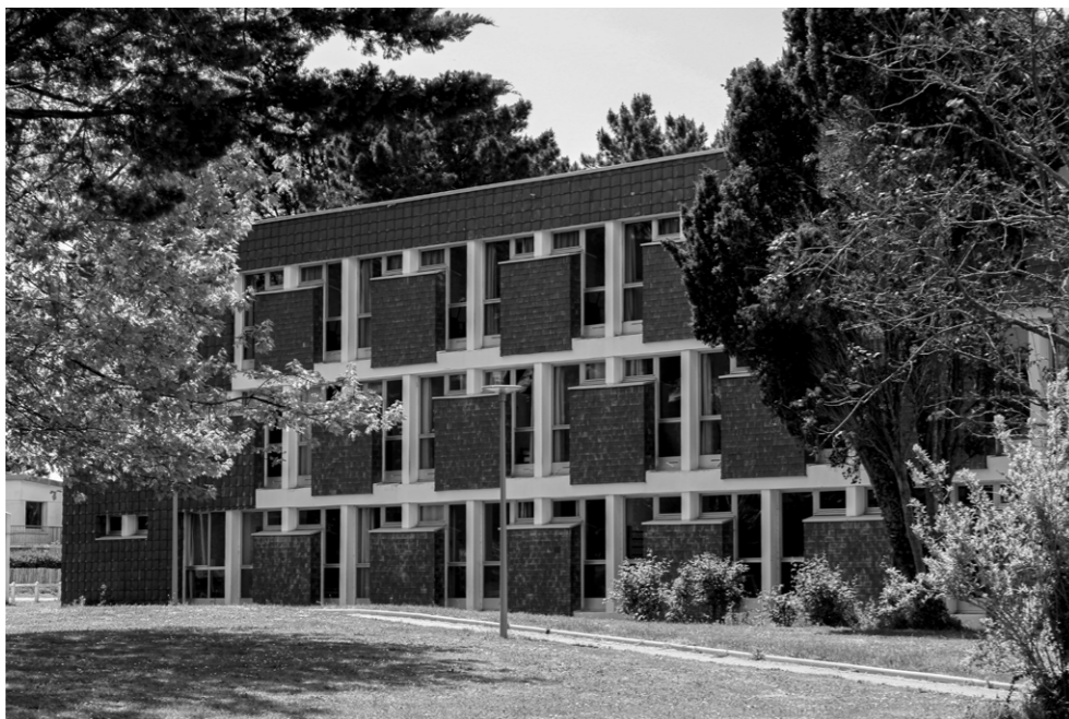
Chambres de l'École de Voile de Saint-Pierre-Quiberon
