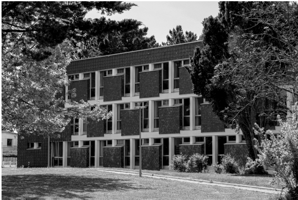
Chambres de l'École de Voile de Saint-Pierre-Quiberon
