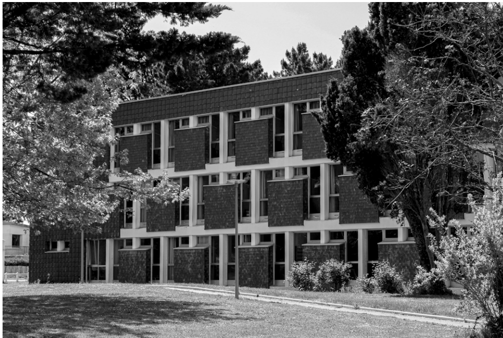
Chambres de l'École de Voile de Saint-Pierre-Quiberon
