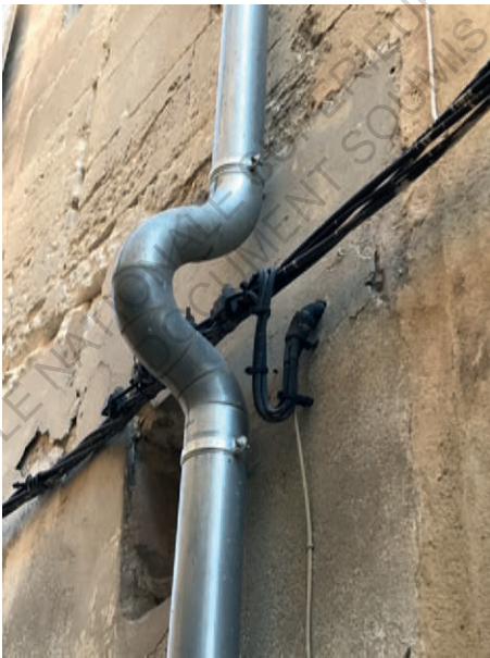
Gouttière posée après des câbles de téléphonie à Arles
