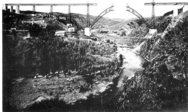
Imp. Photo. A. G. F. 1884, 35, rue Solferino, Paris. VUE GÉNÉRALE LORSQUE LE MONTAGE ÉTAIT ARRIVÉ AU PANNEAU 11
