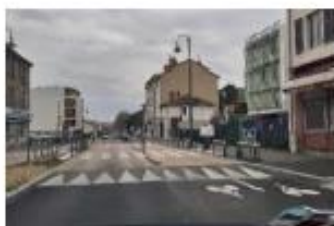
Traversée sécurisée, plateau et aménagements cyclables devant une école
