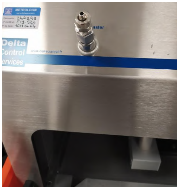
Figure 22 : Fuite dans le raccord Stäubli®
