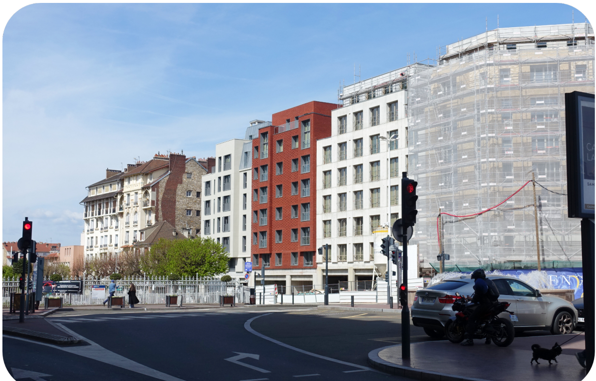
Vue sur l'entrée de la rue, avril 2023. Photo personnelle
